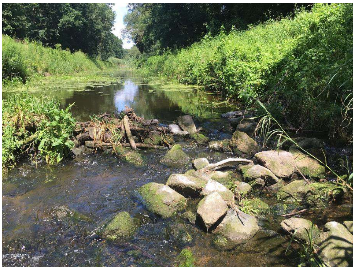
Obr. 5.8 Pohľad proti prúdu na jestvujúci objekt v staničení rkm 17,220
