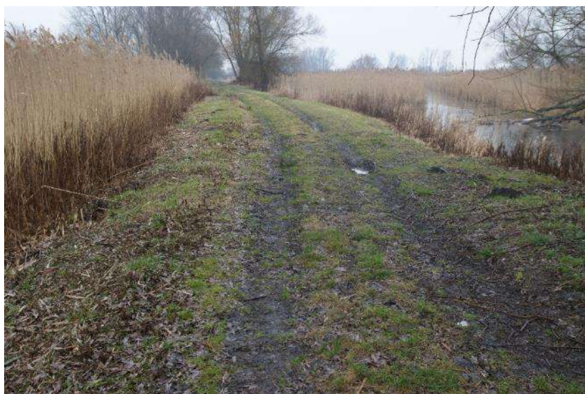
Obr. 3.8 Pravý breh Zohorského kanála v staničení rkm 15,250 (stav 02/2018) autor © Ing. Dušan Valachovič
