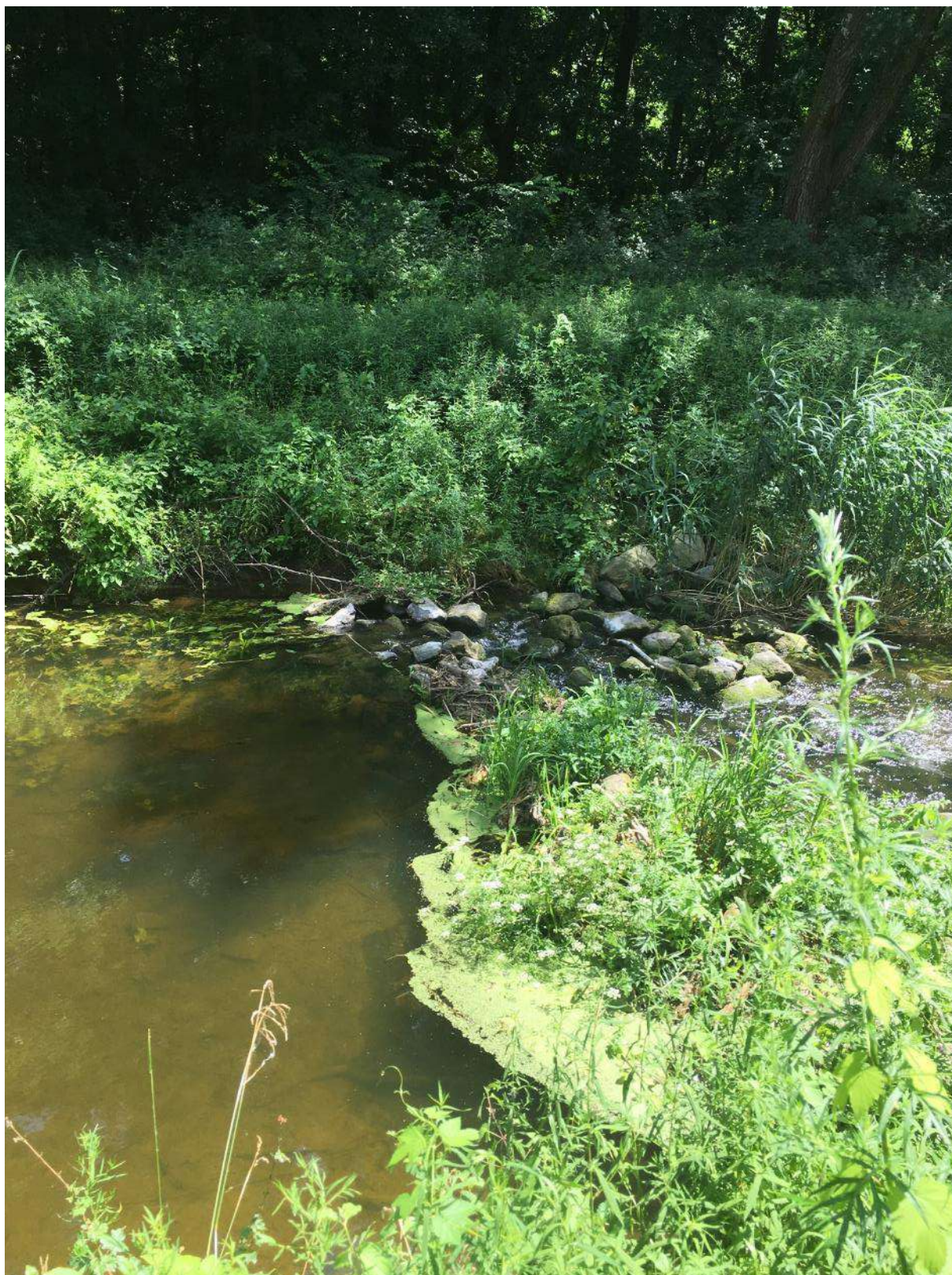
Obr. 5.7 Bočný pohľad na jestvujúci objekt v staničení rkm 17,220
