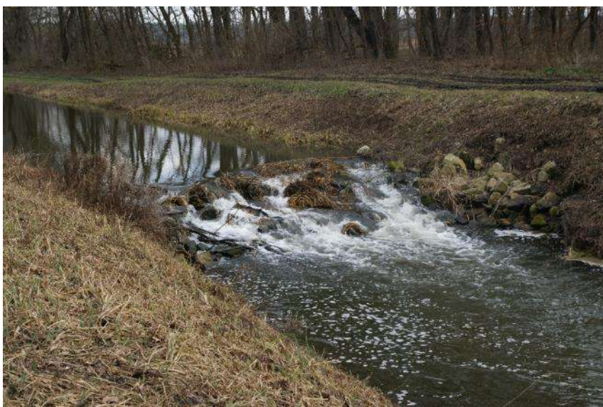
Obr. 3.20 Stupeň v staničení rkm 17,220 (stav 02/2018) autor © Ing. Dušan Valachovič
