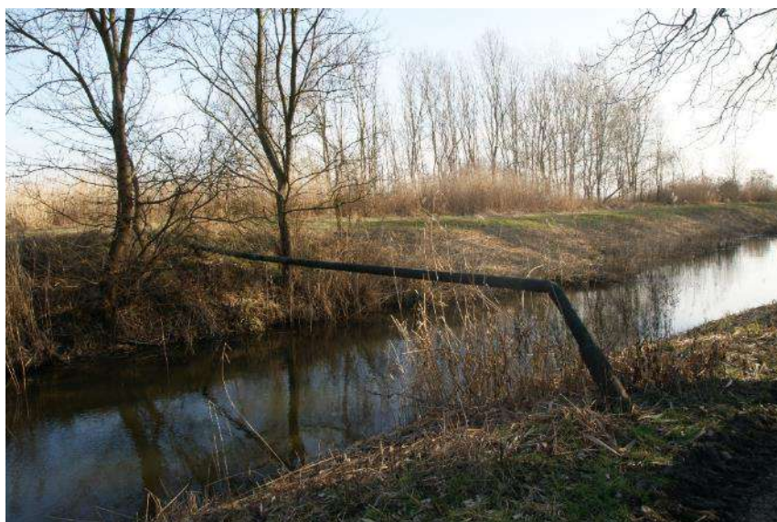
Obr. 3.13 Križovanie plynovodu cez koryto Zohorského kanála v rkm 16,765 (stav 02/2018) autor © Ing. Dušan Valachovič
