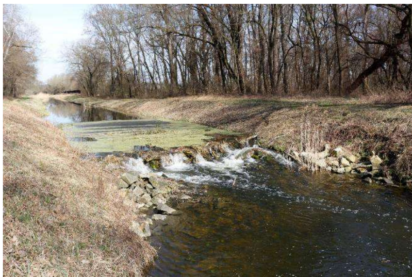
Obr. 3.21 Stupeň v staničení rkm 17,220 (pohľad z pravého brehu – stav 03/2019)
