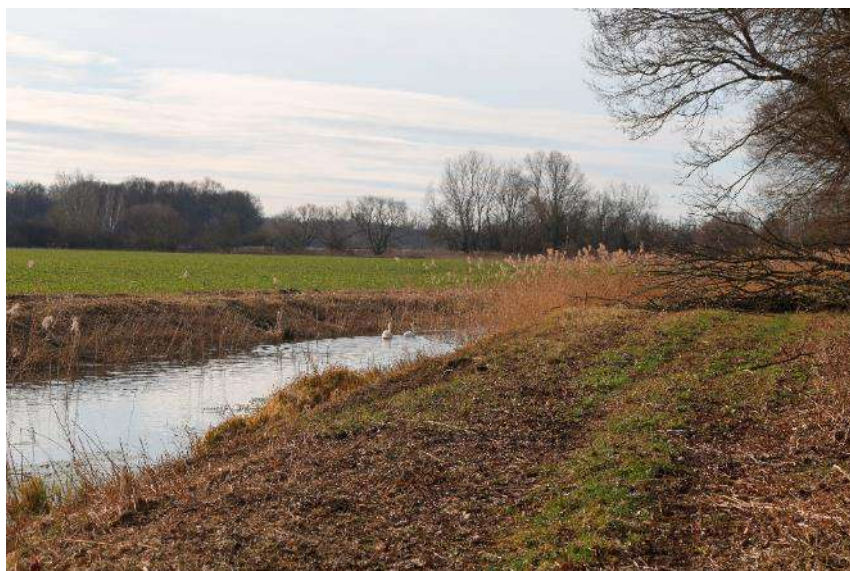
Obr. 3.12 Koryto Zohorského kanála v oblasti staničenia rkm 16,530 (pohľad z pravého brehu – stav 02/2020)
