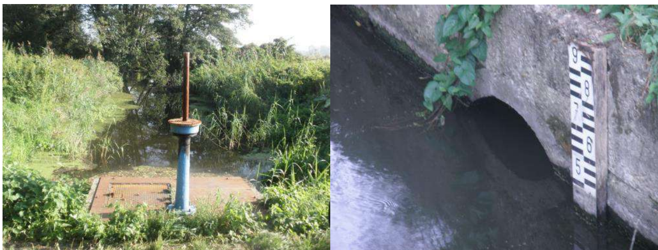
Obr. 3.4 Odberný objekt na vtoku do Rudávky (foto – Manipulačný poriadok pre vodnú stavbu Hať na jazere Centnúz, SVP, š. p. 2012)
