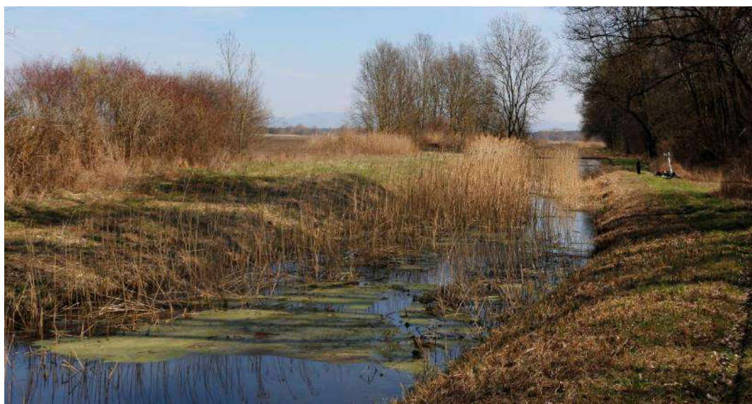
Obr. 3.17 Zarastené koryto Zohorského kanála v oblasti staničenia rkm 16,800 (stav 03/2019)
