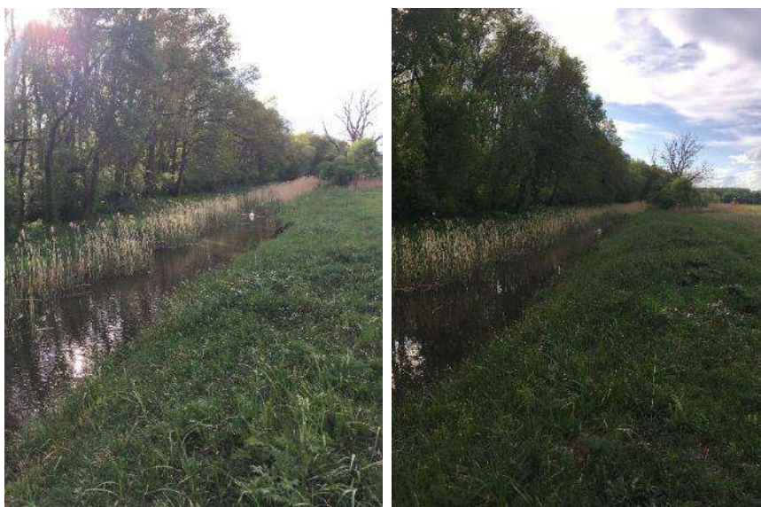
Obr. 3.11 Koryto Zohorského kanála v oblasti staničenia rkm 16,000 (pohľad z pravého brehu – stav 05/2020)
