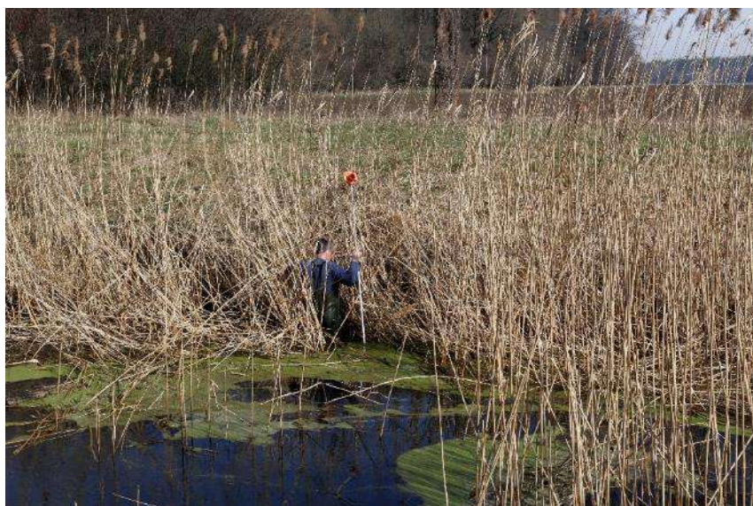
Obr. 3.16 Zarastené koryto Zohorského kanála v oblasti staničenia rkm 16,800 (stav 03/2019)
