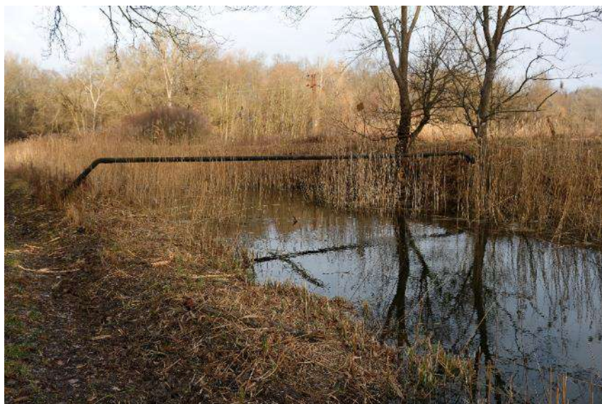
Obr. 3.15 Križovanie plynovodu cez koryto Zohorského kanála v staničení rkm 16,765 (pohľad z prav. brehu – stav 02/2020)
