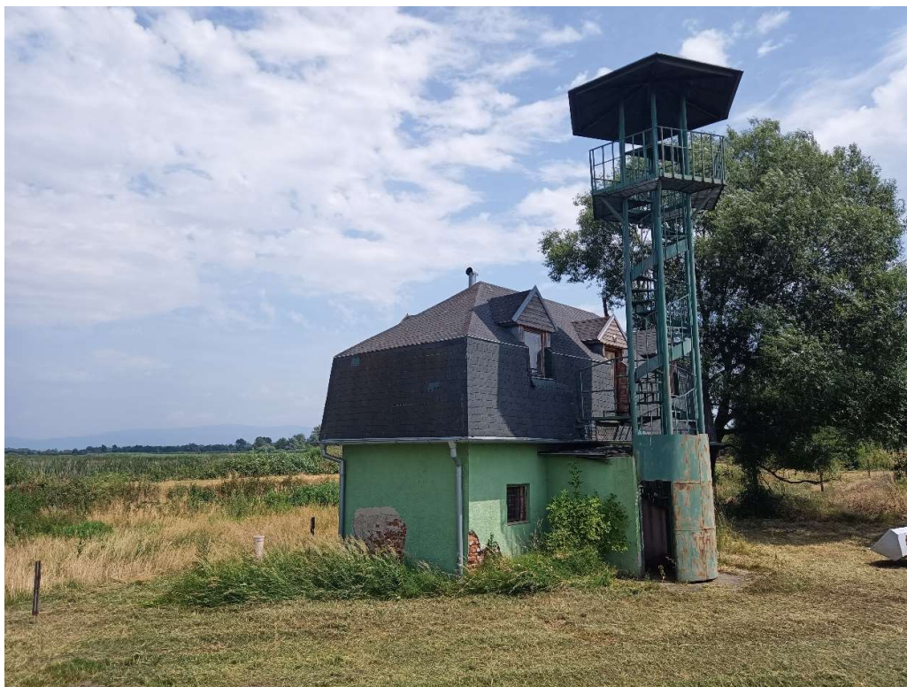
Terénna stanica s monitorovacou vežou – súčasný stav
