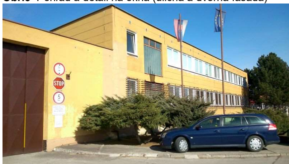
Obr.3 Pohľad a detail na okná (uličná a dvorná fasáda)
