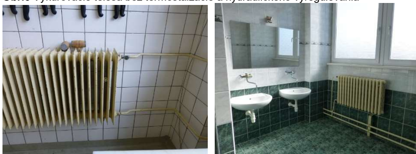
Obr.6 Vykurovacie telesá bez termostaizácie a hydraulického vyregulovania
