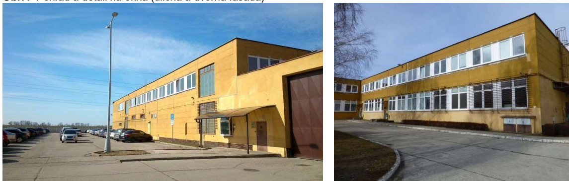
Obr.4 Pohľad a detail na okná (uličná a dvorná fasáda)
