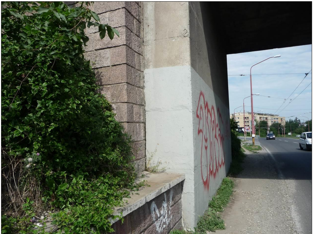
Foto č.22. TÚ 2841; km 10,219
