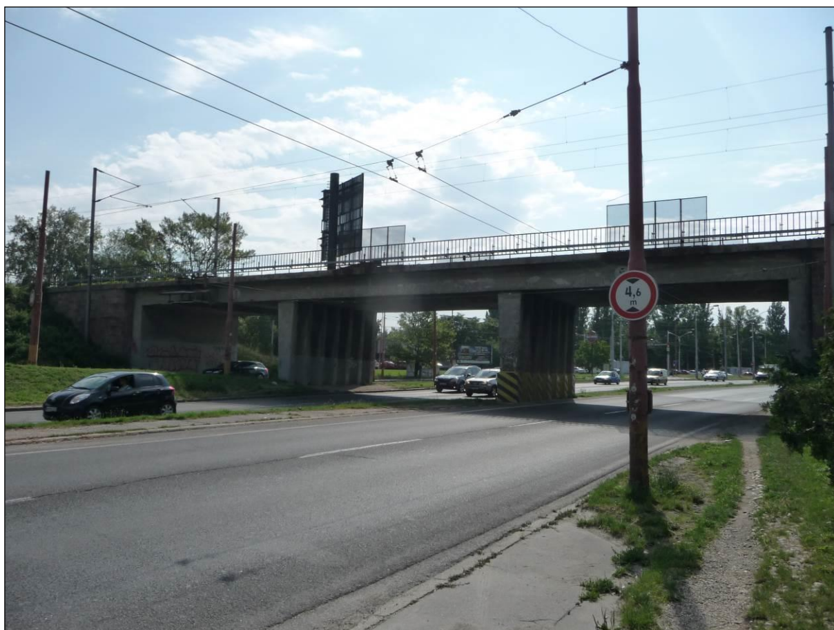
Foto č.1. TÚ 2841; km 10,219
