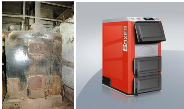
Obr. 23: Inštalovaný kotol pôvodný, nový – ilustračné foto
