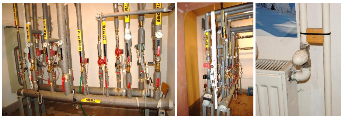
Obr. 79: Rozdeľovač/zberač, vedenie a odovzdávanie tepla
