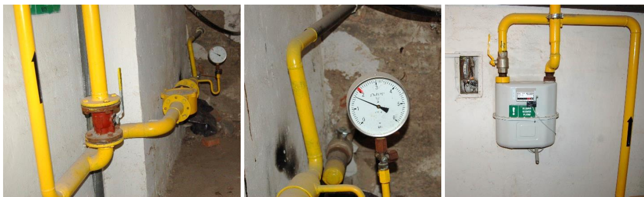
Obr. 75: HUP, tlakomer, fakturačný plynomer
