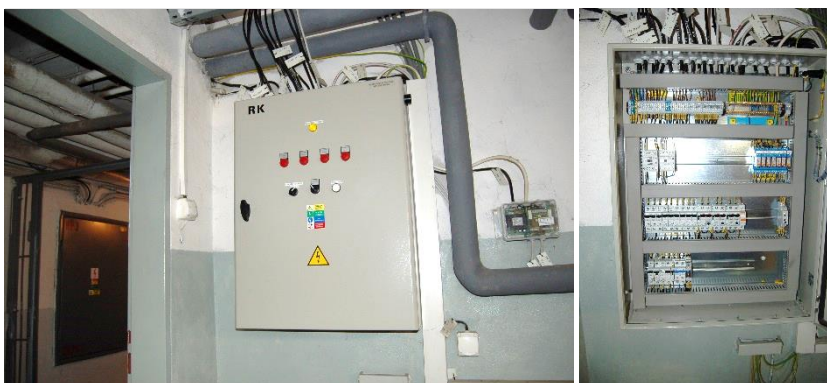
Obr. 43: Rozvodná skriňa
