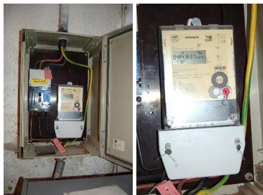
Obr. 86: Meranie spotreby elektriny pre chod kotolne
