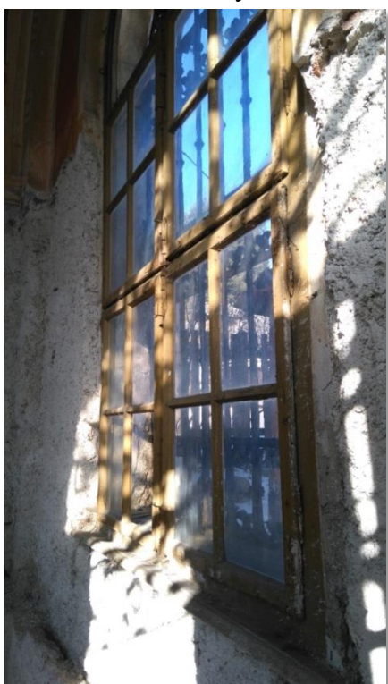
Detail okna a sanačných omietok /foto- február 2017/
