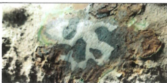
Obr. 2 – detail z obr. 1 výrazná jamková korózia vonkajšieho povrchu
