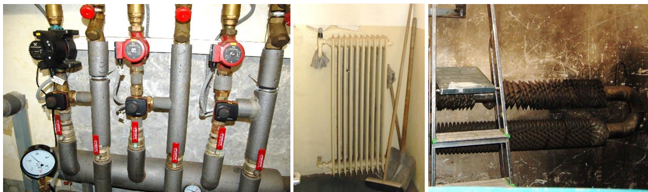
Obr. 8: Vymenené čerpadlo č.1 (vetva č.3) a čerpadlo č.3 (vetva č.1):
