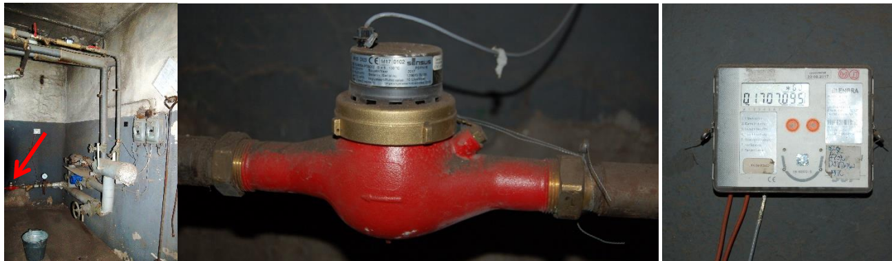
Obr. 16: MT1 – meranie množstva vyrobeného tepla
