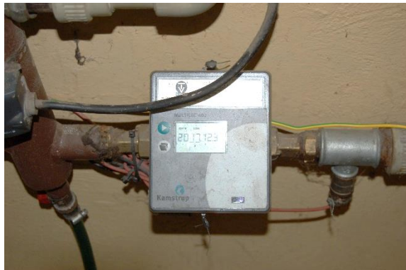
Obr. 26: MT1 – meranie množstva vyrobeného tepla
