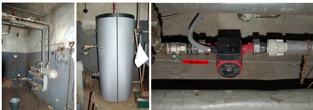
Obr. 21: Vyvedenie tepla, ohrev TV cirkulačné čerpadlo
