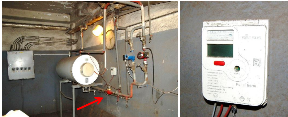
Obr. 36: MT2 – meranie množstva tepla na ohrev TV
