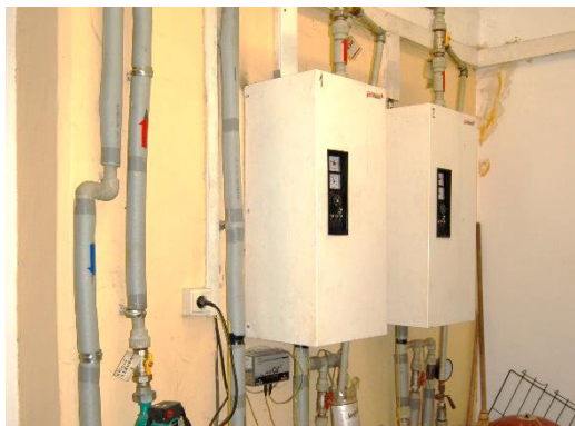
Obr. 28: Inštalované kotly
