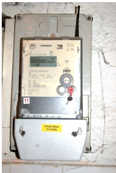
Obr. 19: Fakturačné meranie spotreby elektriny v kotolni
