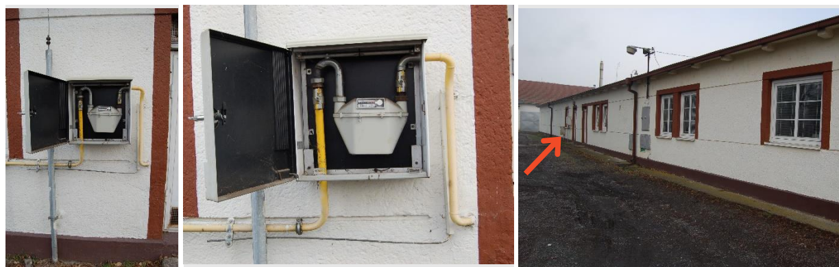
Obr. 67: Podružný plynomer, podružný plynomer
