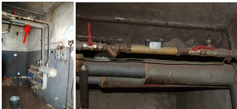
Obr. 17: MT2 – Meranie množstva tepla pre ohrev TV
