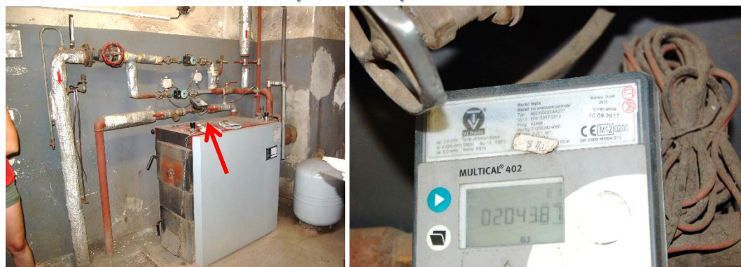
Obr. 35: MT1 – meranie množstva vyrobeného tepla
