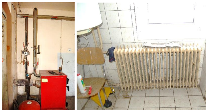
Obr. 78: Vывedenie a odovzdávanie tepla
