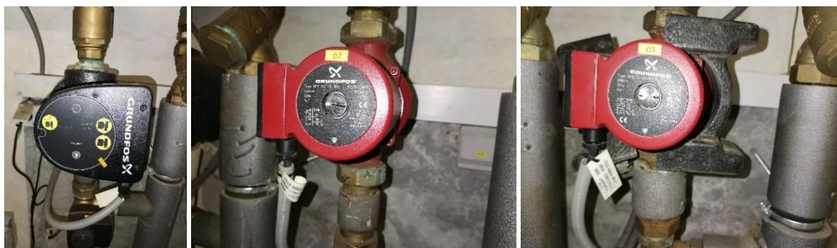
Obr. 8: Vymenené čerpadlo č.1 (vetva č.3) a čerpadlo č.3 (vetva č.1):
