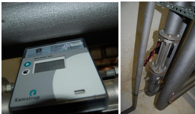
Obr. 4: MT1 – meranie množstva vyrobeného tepla
