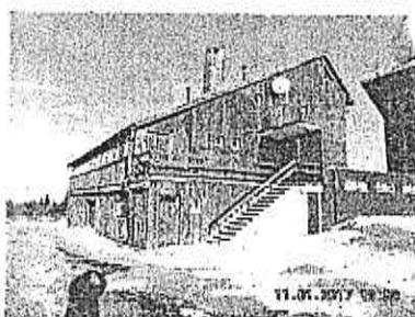
Bočný pohľad na budovu
