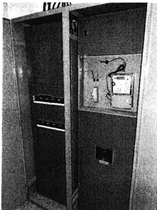
Obrázok 15 – Priestor pre inštaláciu merania spotreby EE – hlavný rozvádzač a fakturačné meradlo (3F)
