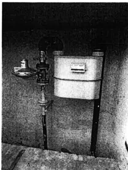
Obrázok 16 – Fakturačný plynomer G10
