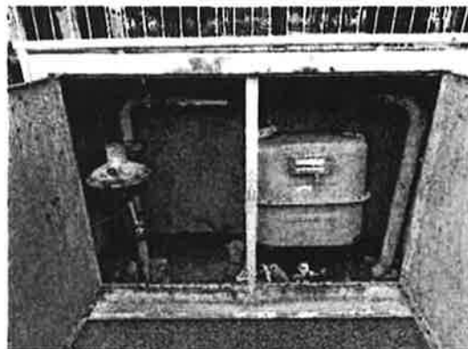
Obrázok 6 – Fakturačný merač zemného plynu G10, Pavilón B
