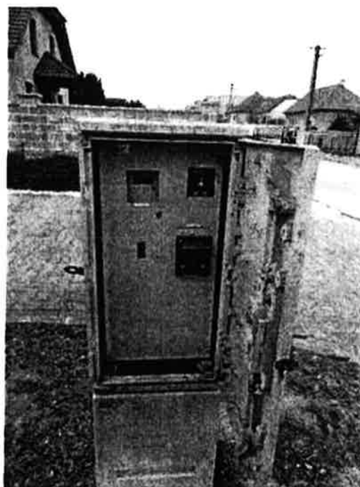
Obrázok 4 – Fakturačný merač elektrickej energie (3F)
