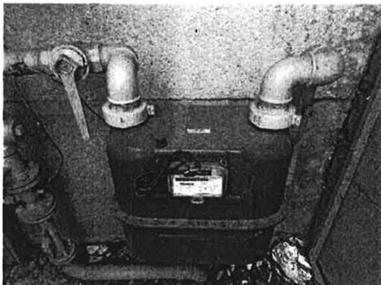
Obrázok 14 – Fakturačný plynomer G10
