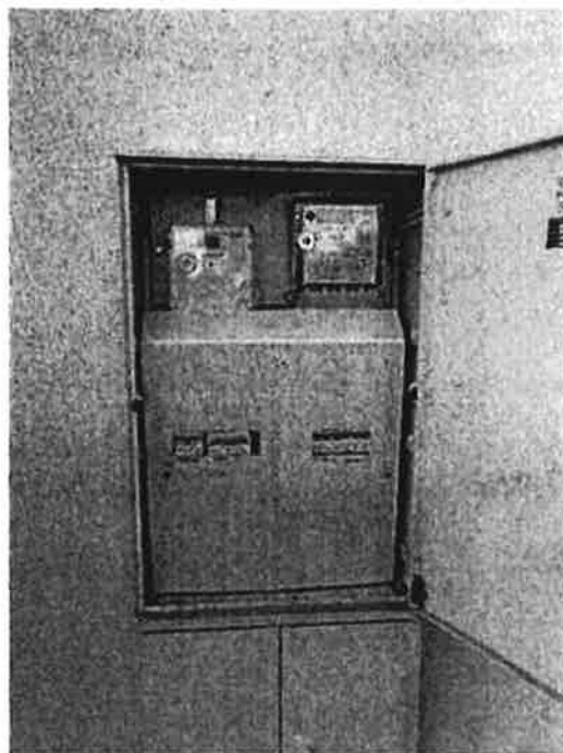
Obrázok 23 – Fakturačné meradlo elektrickej energie
