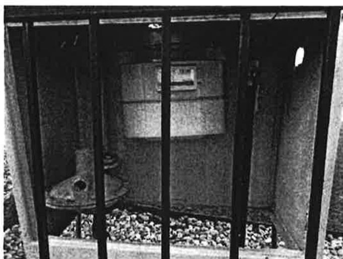
Obrázok 18 – Fakturačný plynomer – priestor pre inštaláciu merania
