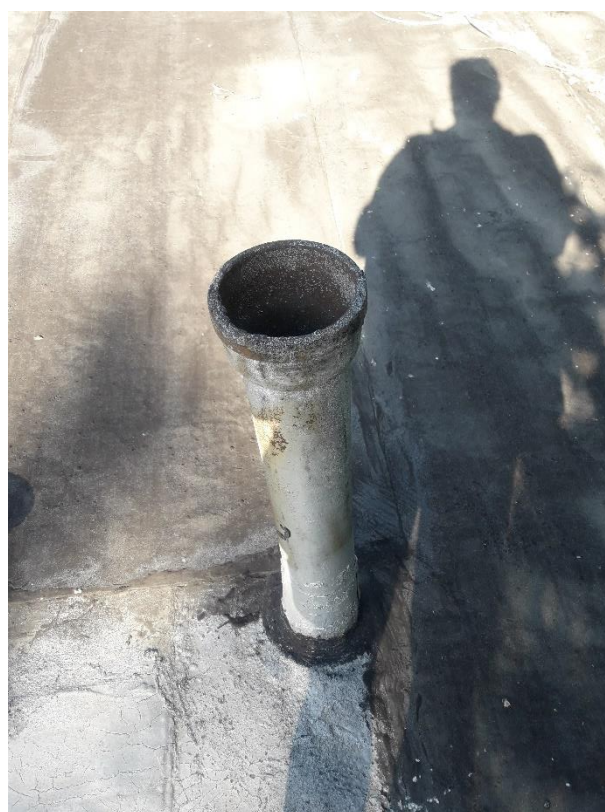
Obr. č. 2 Odvetranie na ploche strechy – 2 ks (zachovať)
