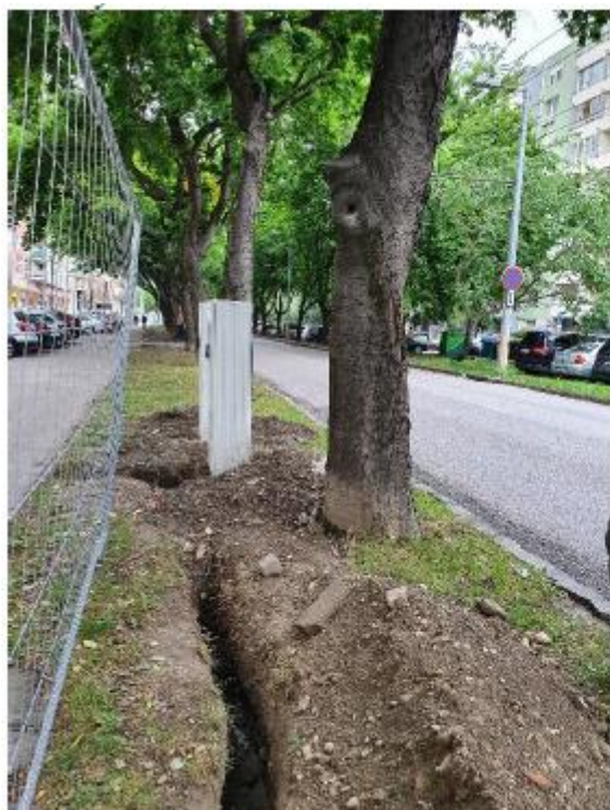
výkopy v tesnej blízkosti stromov
