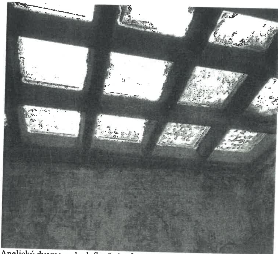
Anglický dvorec v chodníku č. 4 – foto odspodu - výsek
