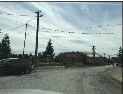
OBR. - KONIEC RIEŠENÉHO ÚSEKU ČASŤ "1"
