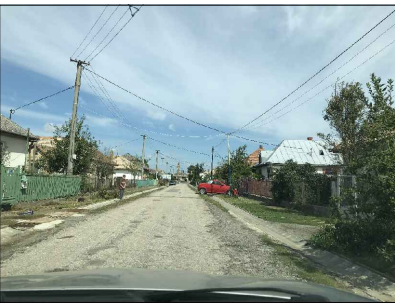
OBR. - ÚSEK ČASŤ "2" - NOVÁ ULICA
