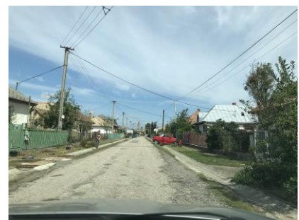
Obr. 3 Úsek časť "2" Nová ulica
