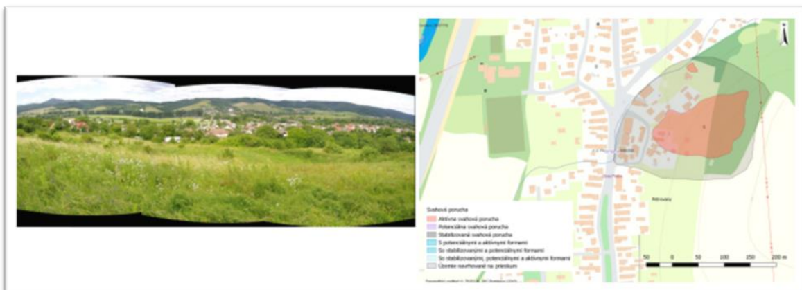
Obr. 6: Havarijná svahová deformácia Petrovany (zdroj: Databáza ŠGÚDŠ)
