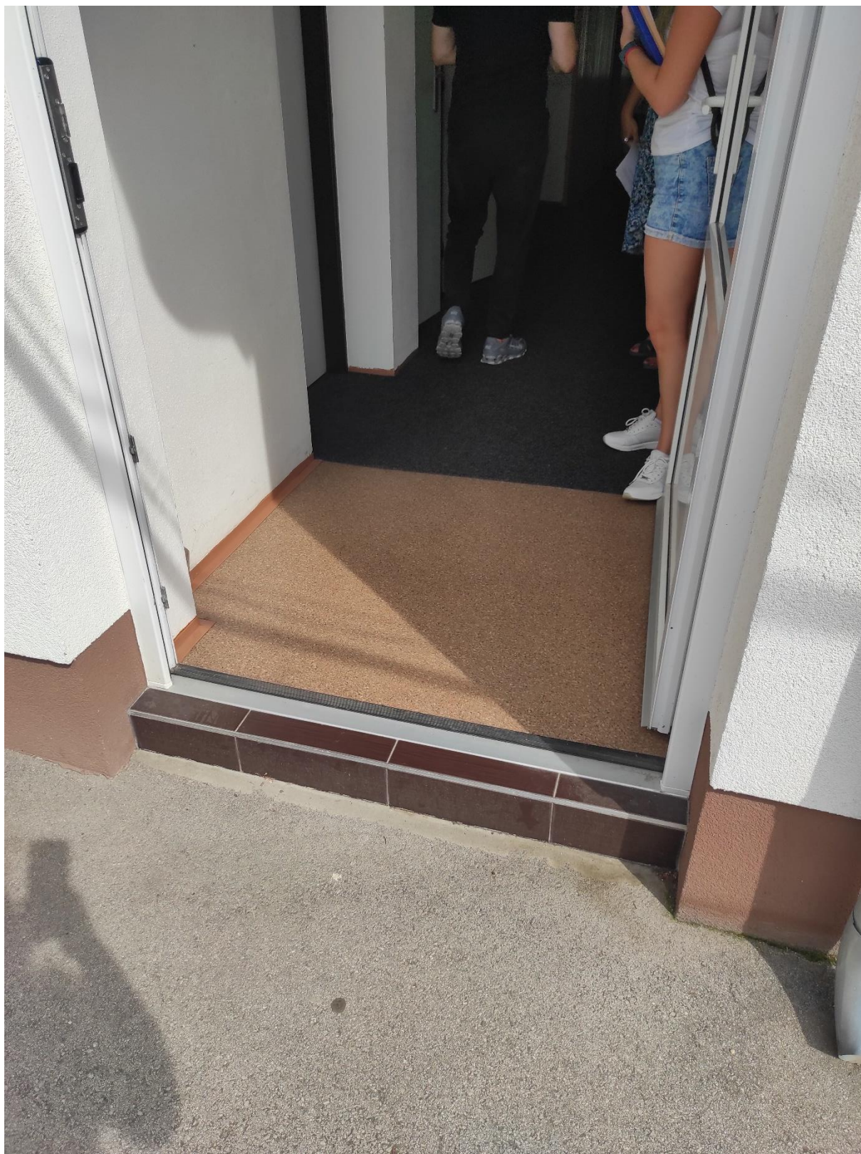
Zadný vstup do budovy školy
