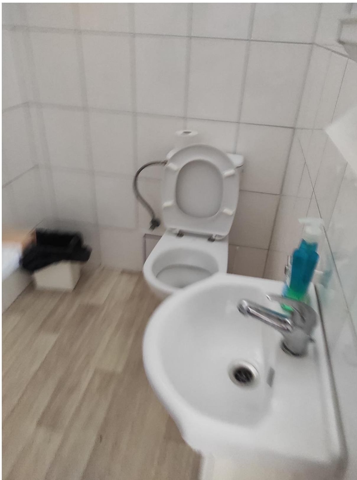
Súčasnú riešenie bezbariérovej toalety
