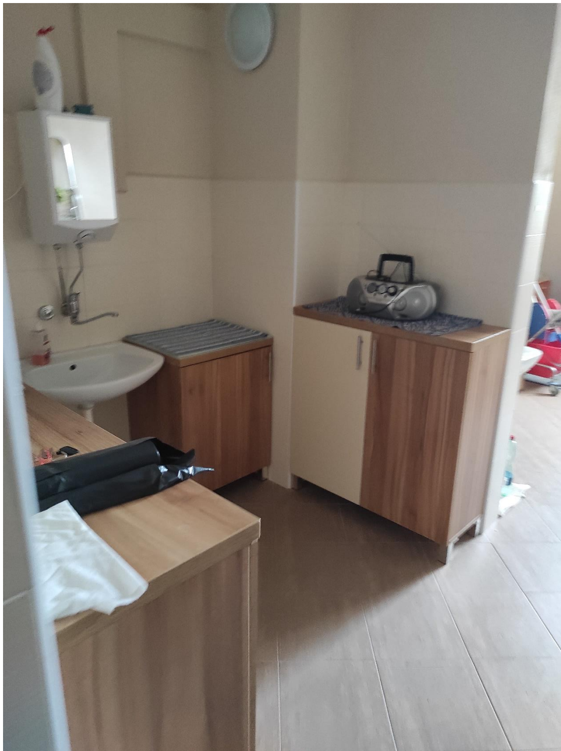
Technická miestnosť na 1. podlaží – navrhované miesto pre dobudovanie bezbariérovej toalety
