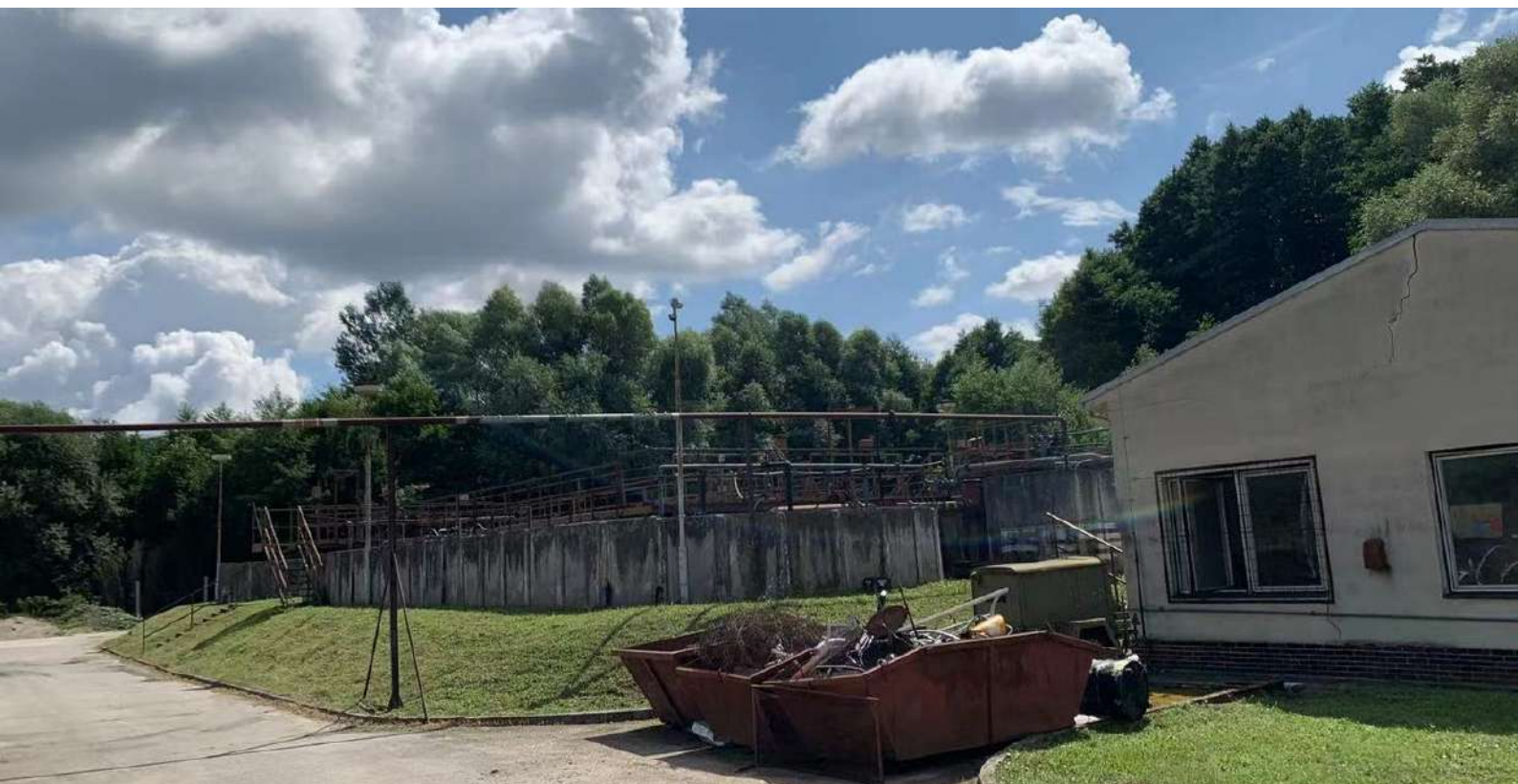
Pohľad na ČOV
