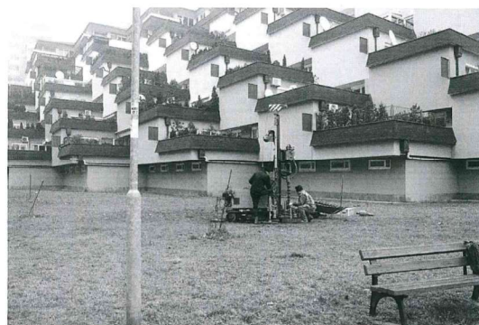
Obr.č.2. Na mieste mokraďového záhonu pri hornom bytovom dome Kaskády sa vykonali prieskumné geologické vrty.
