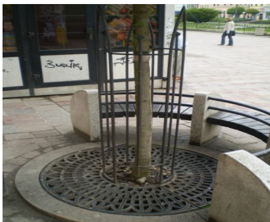
Celkový pohľad na umiestnenie vodorovnej mreže
