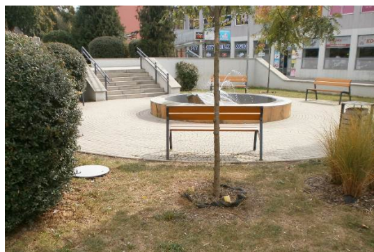
Fontána Opál - šachta - kanalizačná prípojka
