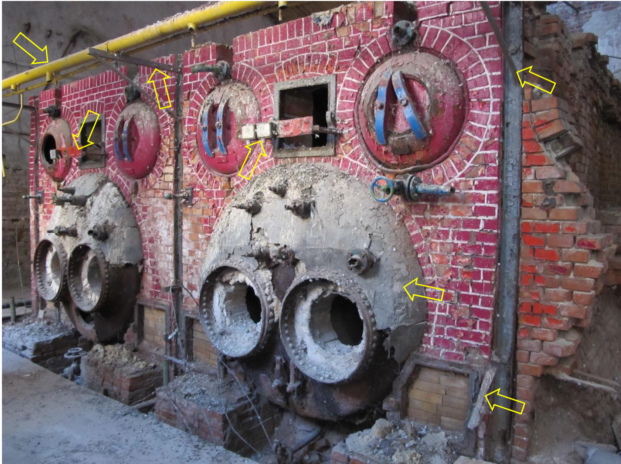
Obr.16.: nepôvodné prvky, ktoré sa odstránia
