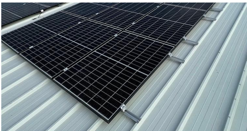
Obrázok 4: Nosná konštrukcia panelov MiniRail
