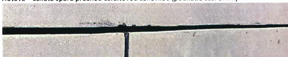
Hotová – zaliata špára pružnou asfaltovou zálievkou (podliatie cca. 5mm)
