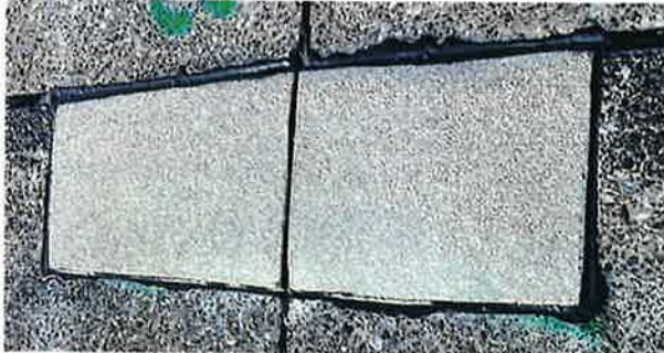
Hotová realizácia po zarezaní po obvode, kompletom zaliatí, zdrsnení povrchu
