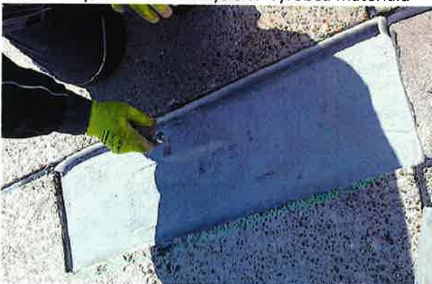
Hotová realizácia po zarezaní po obvode, kompletom zaliatí, zdrsnení povrchu
