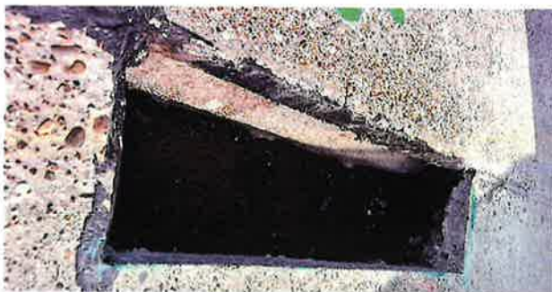
Zalievanie po vrstvách v zmysle TP výrobcu materiálu
