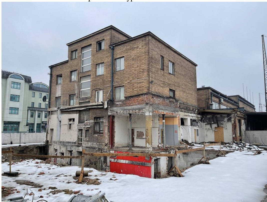
Obr. 3 SV pohľad na výpravnú budovu ŽST Žilina (prebieha asanácia časti budovy v rámci stavby „ŽSR, Dostavba zriaďovacej stanice Žilina – Teplička a nadväzujúcej železničnej infraštruktúry v uzle Žilina“)
