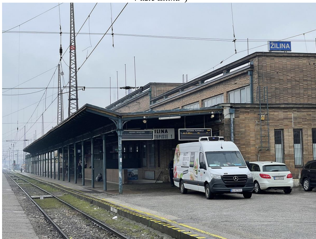
Obr. 4 SZ pohľad na výpravnú budovu ŽST Žilina
