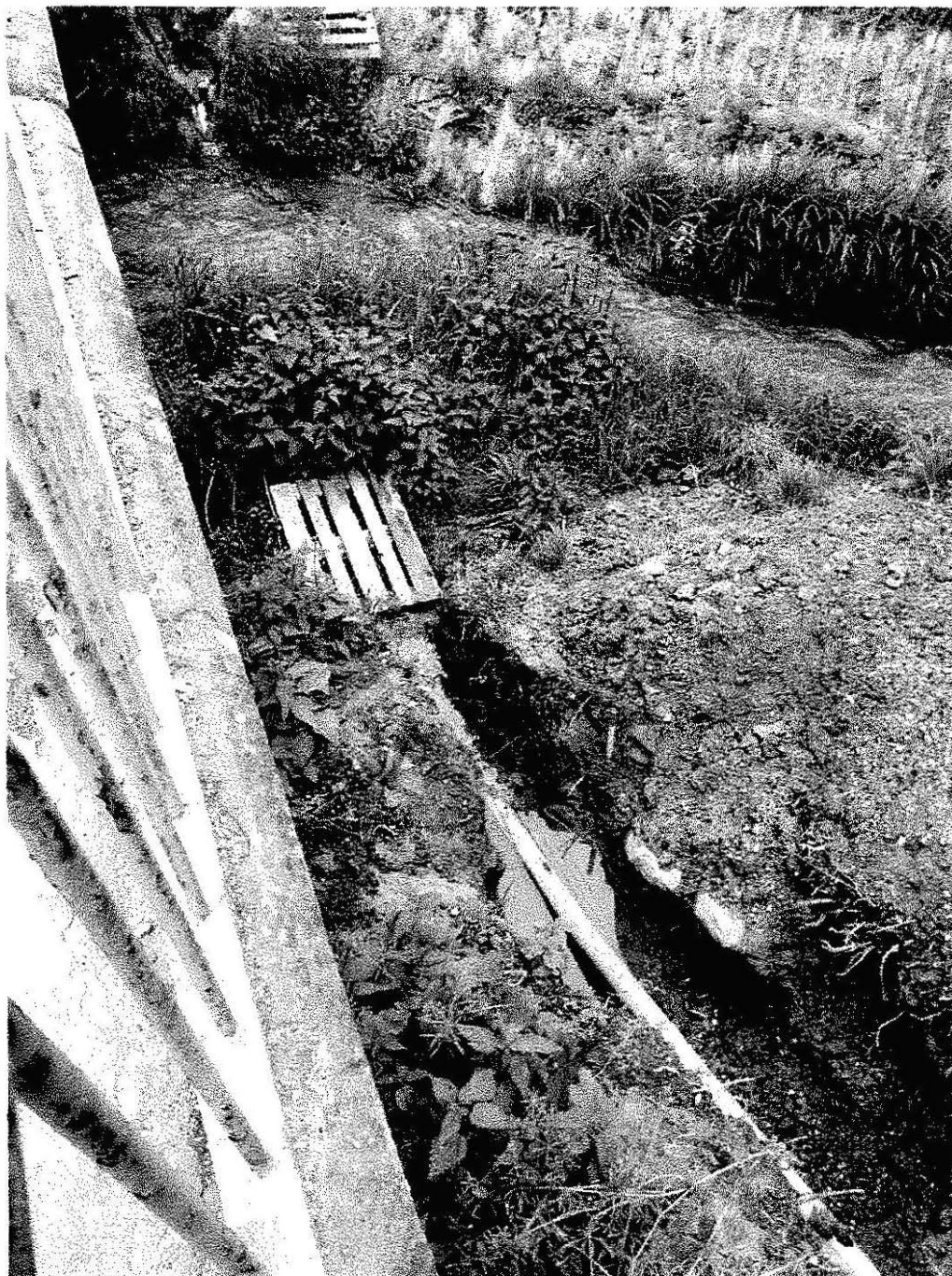
Obr. 2 Ručný výkop káblového vedenia
