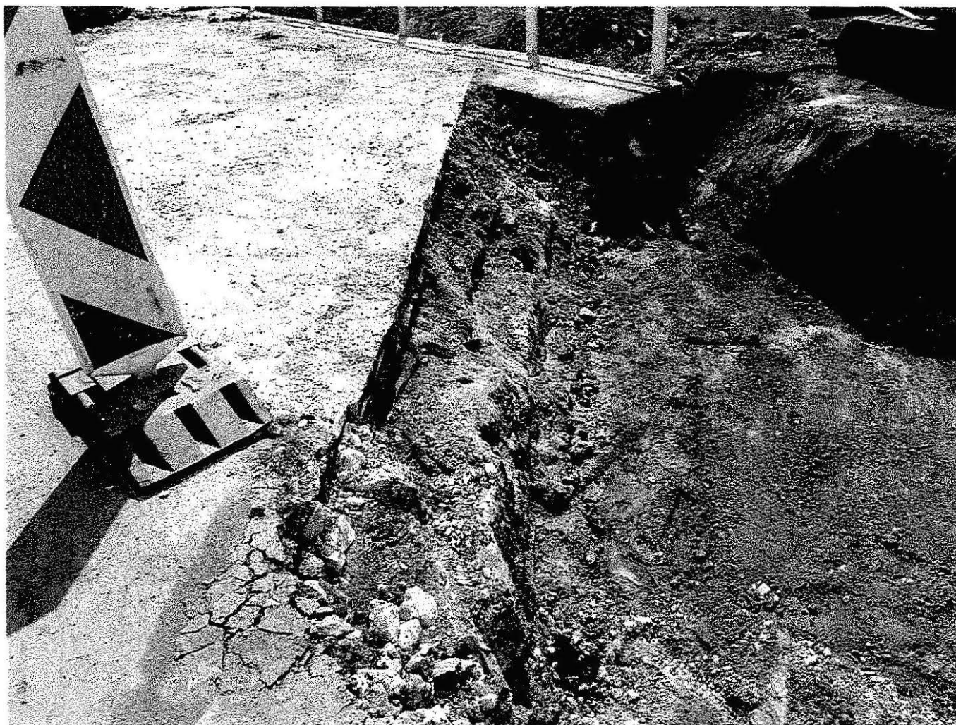
6.) Nadbetónávka pôvodnej opory
