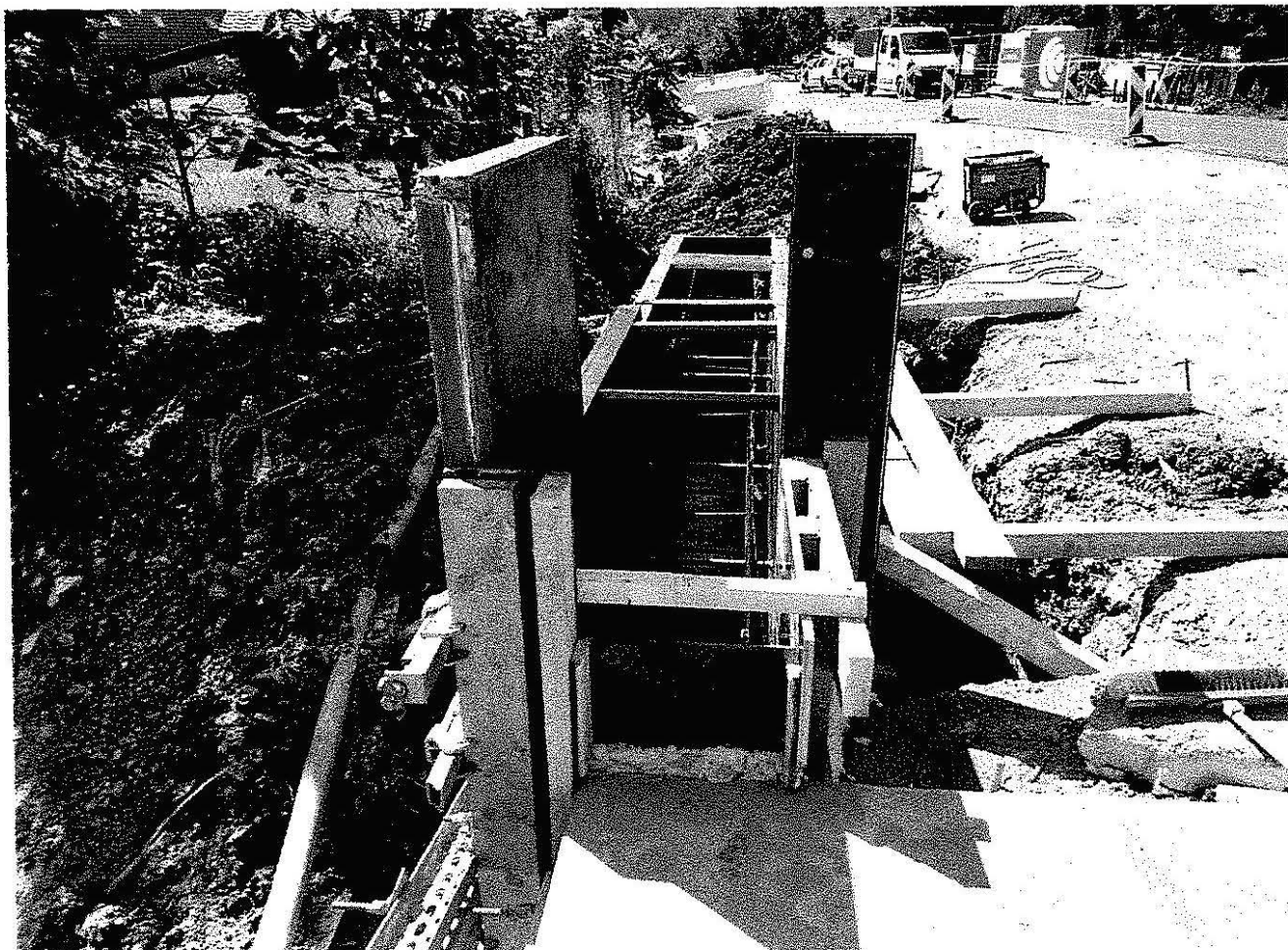
Výstuž a debnenie predĺženia krídla
