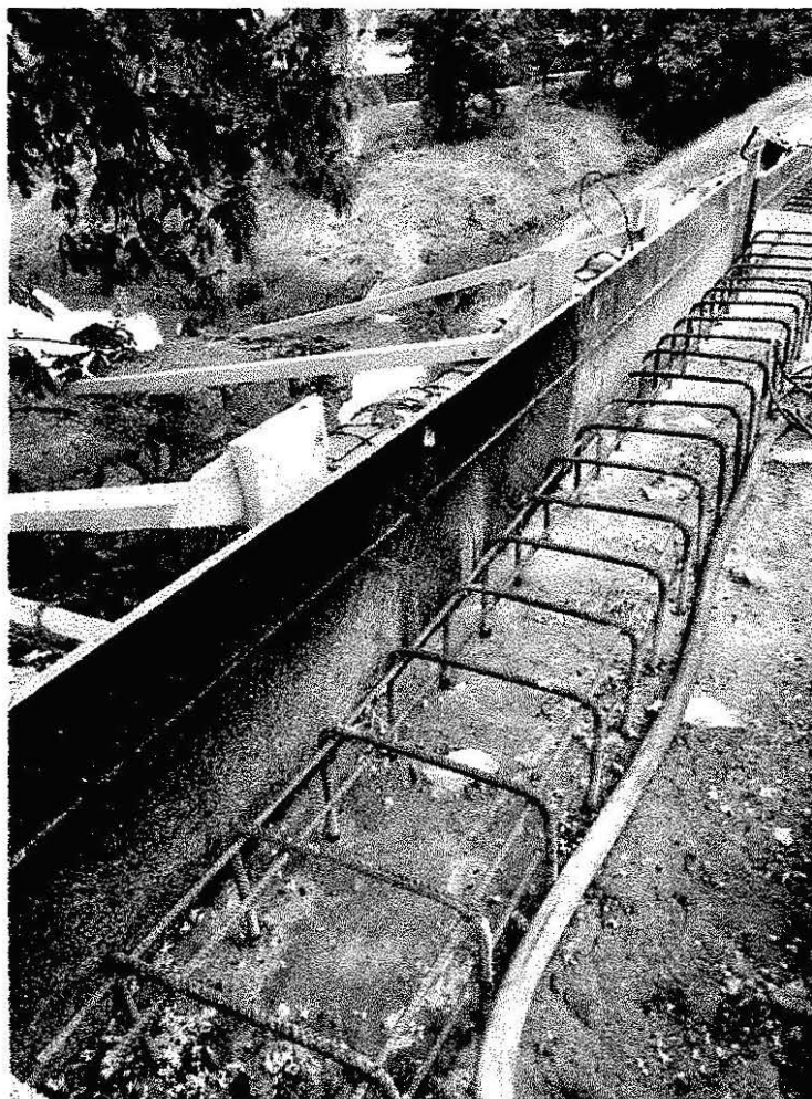
Nový stav – viazanie armatúry
