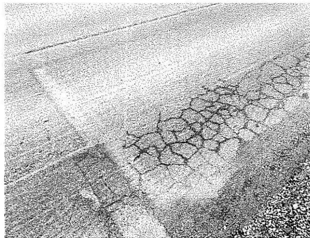
2. Odfrezovaný povrch v mieste sieťových rozpadov
