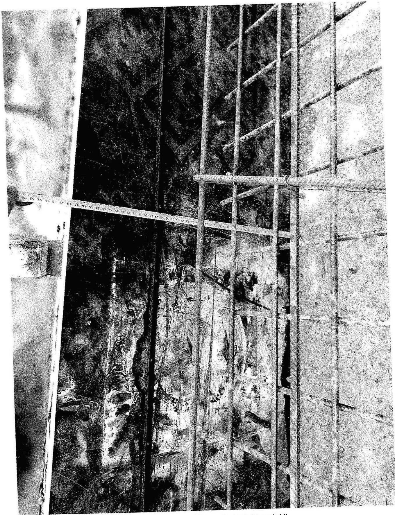
Nový stav – výška nadbetonávky na křídle
