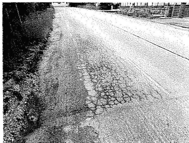
2. Odfrezovaný povrch v mieste sieťových rozpadov
