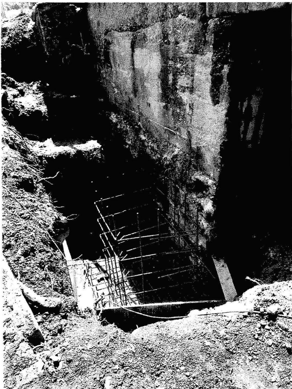
Obr. č.2 – Vlepené kotvenie pre základ rozšírenia opory č.2
