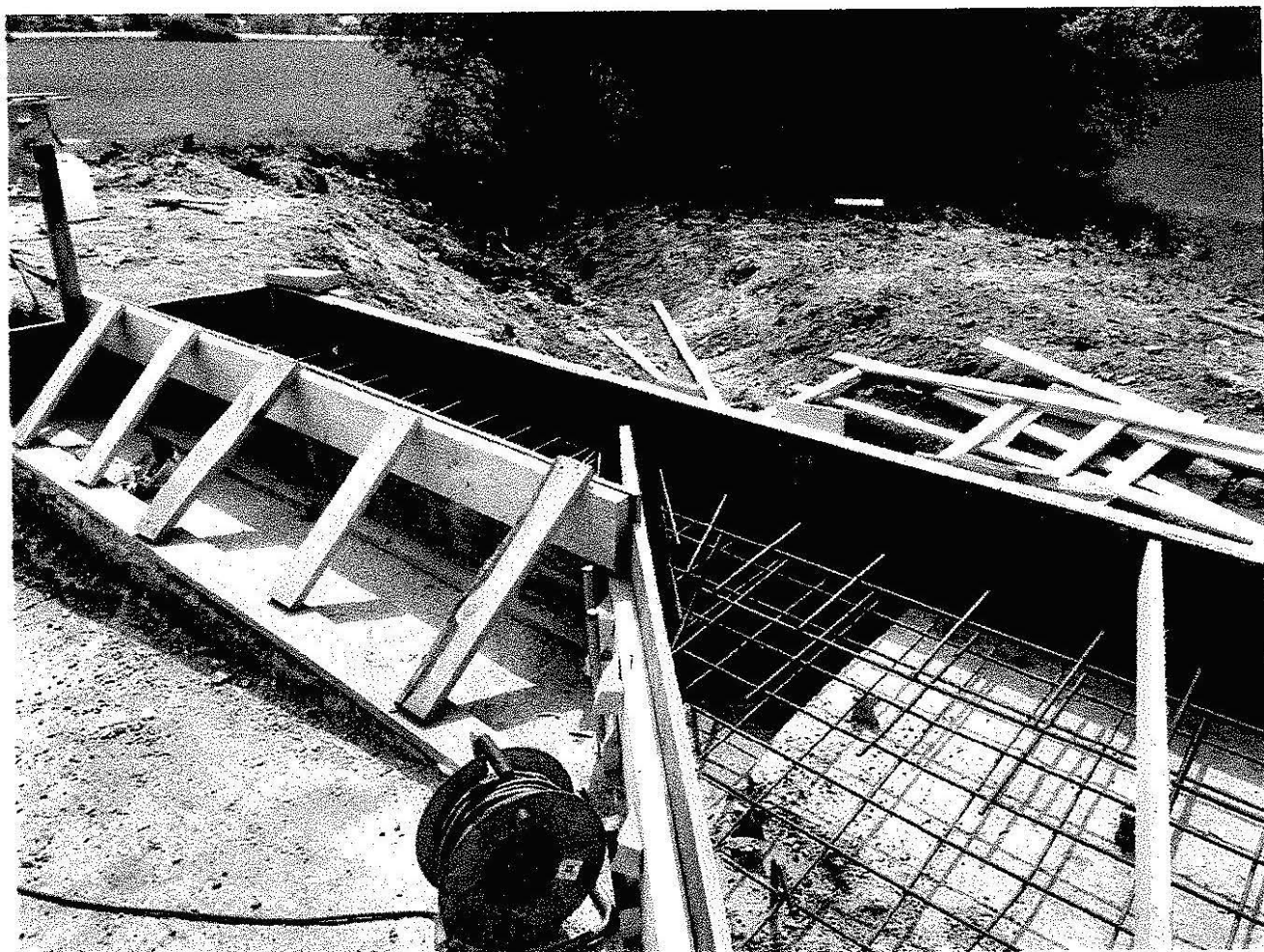
1.) Stav po zrealizovaní armatúry a debnenia
