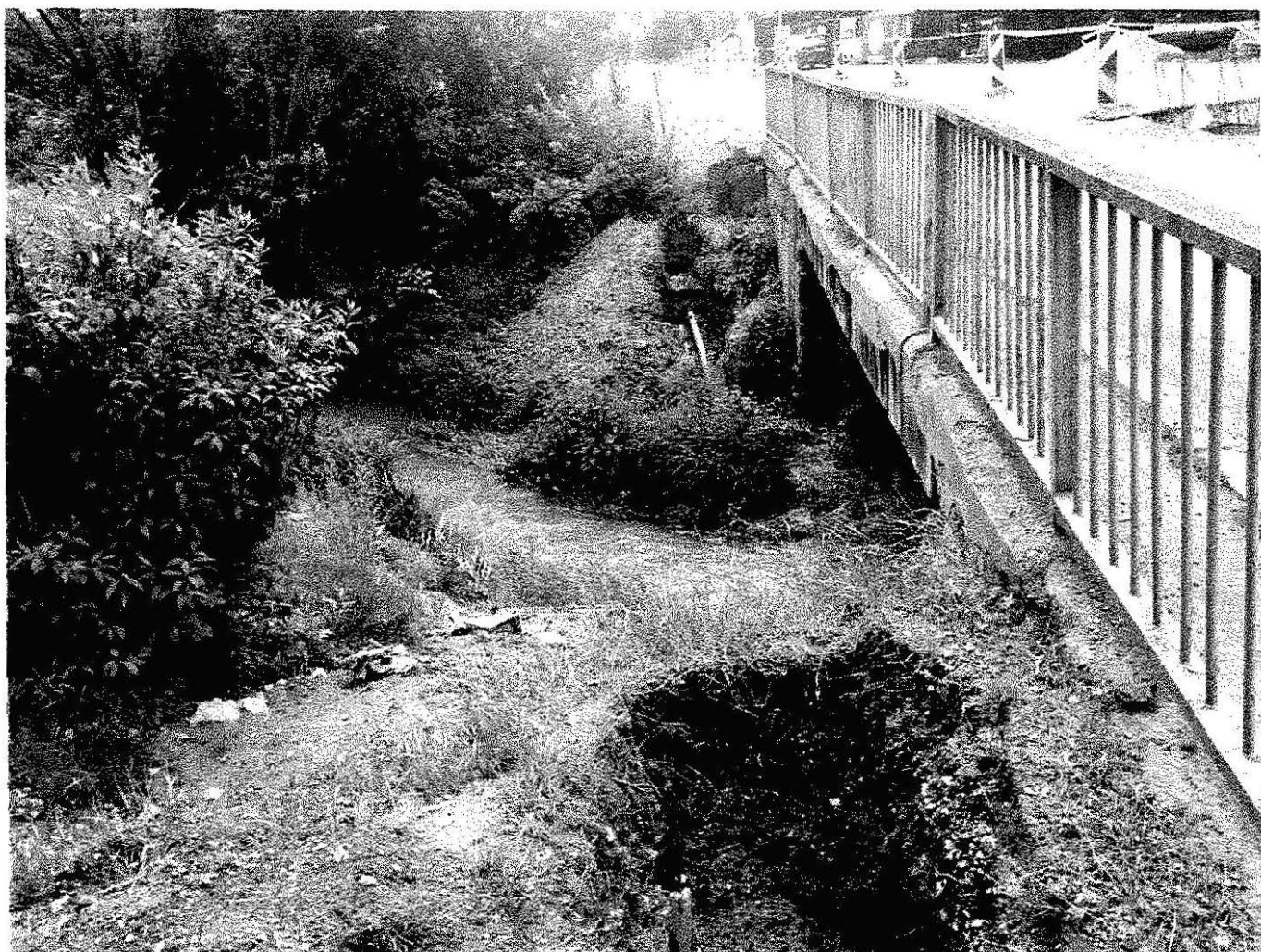
Obr. 1 Ručný výkop káblového vedenia
