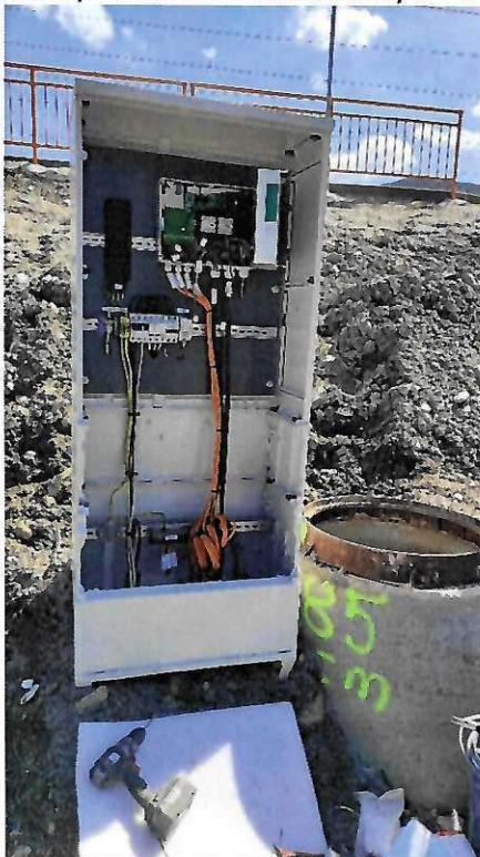
Zrealizované čerpace stanice s dvoma čerpadlami a komplet riadením s nadradeným rozvádzačom:
