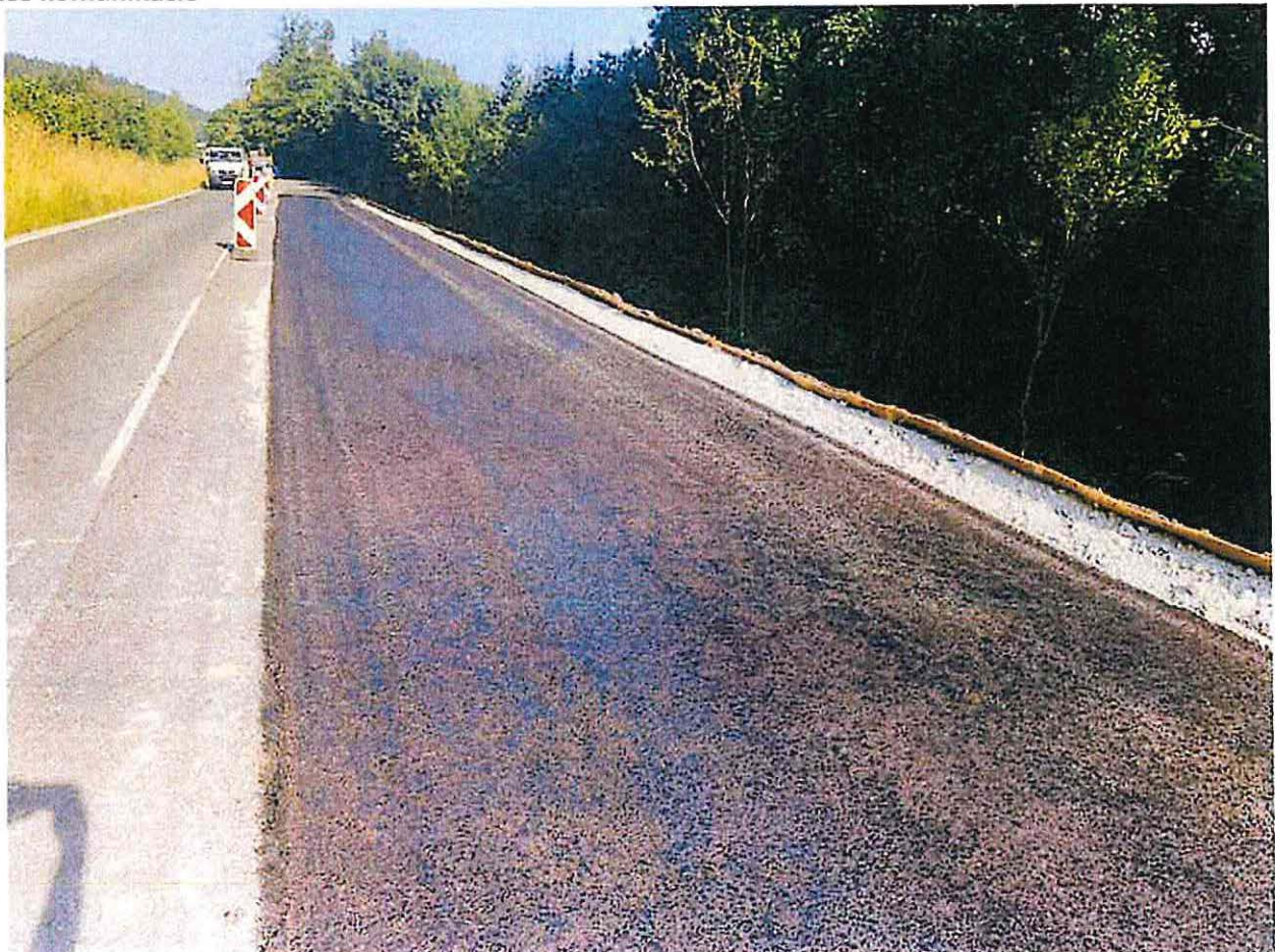
Realizácia vrstvy zo štrkodrvy , CBGM C5/6 a ložnej asfaltových vrstiev v km 6,423 – 6,572 výmena utrhnutej krajnice komunikácie
