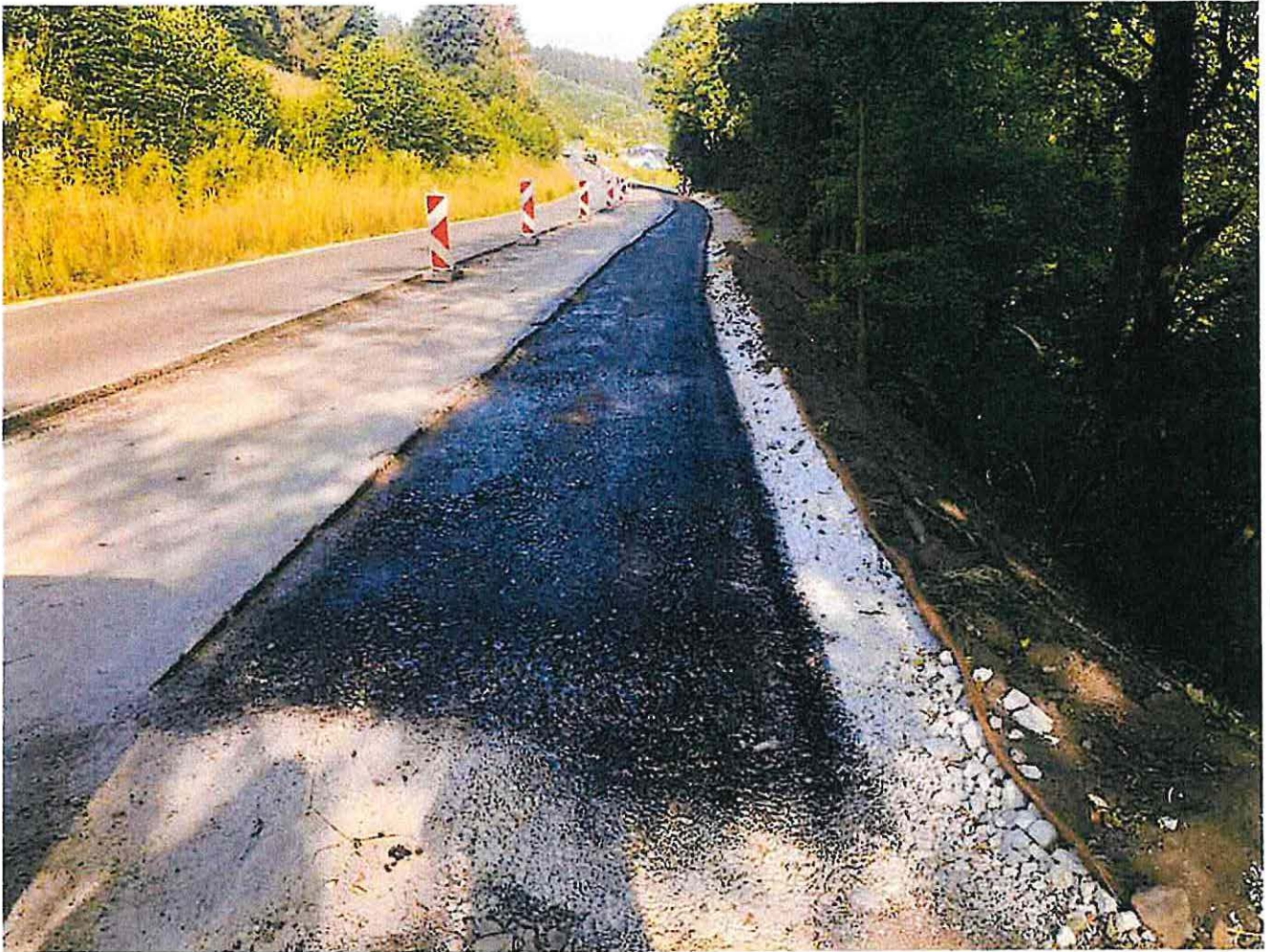
Realizácia vrstvy zo štrkodrvy , CBGM C5/6 a ložnej asfaltových vrstiev v km 6,423 – 6,572 výmena utrhnutej krajnice komunikácie
