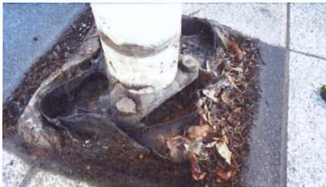
F3 - kotvenie vlakových žrdí – 7 ks
