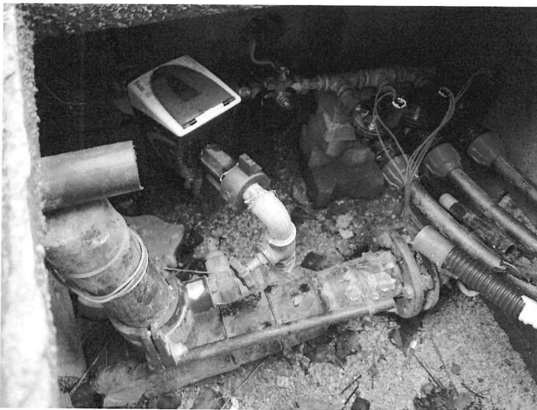
Obr. č.12. Vodovodná šachta na ul. H Melíčkovvej s vodomermom na potrubí BVS, guľovými uzávermi, s prípojkou na kompresor a 3x solenoidmi pre doplňanie troch podzemných nádrží.
