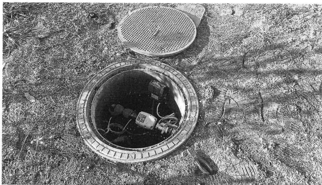
Obr. č.9. Hrdlo podzemnej nádrže s potrubím čerpadla záhradnej závlahy , guľovým uzáverom a prípojkou na kompresor.
