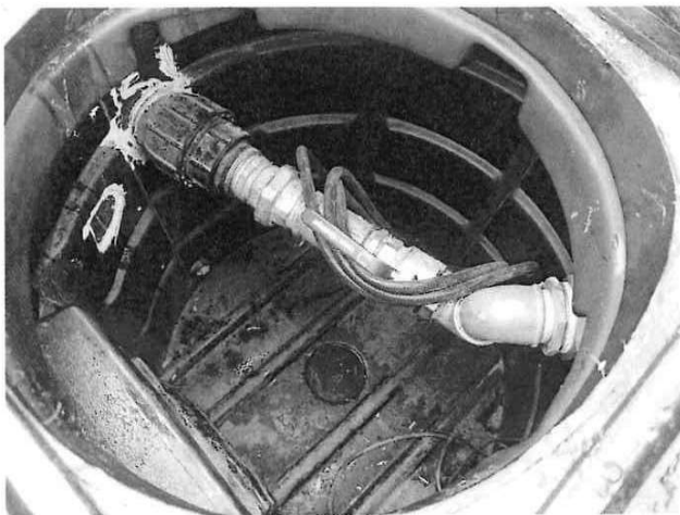
Obr. 1. Pohľad do šachty s uzatváracím guľovým ventilom DN 100 a spätnou klapkou na výtlačnom vodovode PE DN 100.
