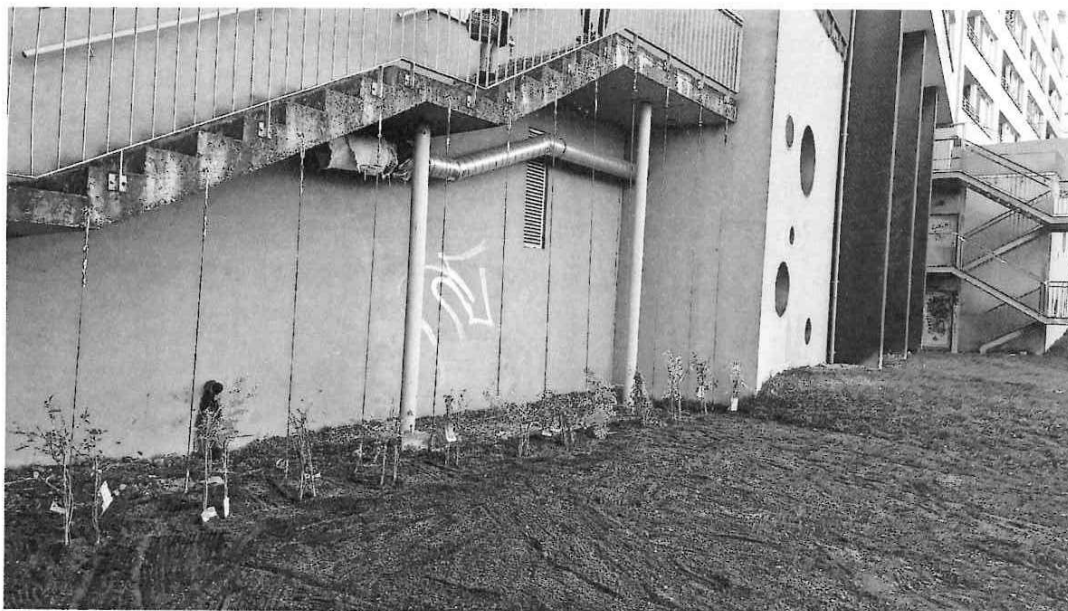
Obr. č.10. Vegetačná stena na oceľovej konštrukcii schodišťa s kvapkovou závlahou.
