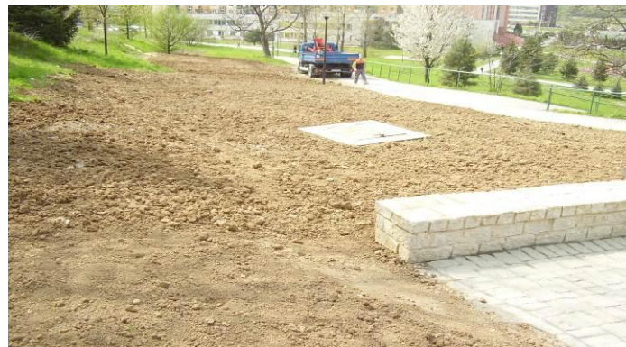
Fontána Angelina - technologická šachta
