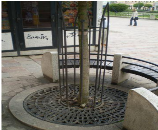
Celkový pohľad na umiestnenie vodorovnej mreže
