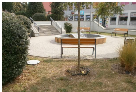
Fontána Opál - šachta - kanalizačná prípojka
