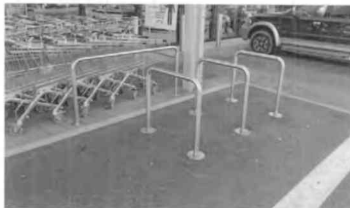
14 Príklad vhodného typu robustnejšieho stojana z pozinkovanej ocele, ktorý vhodne zapadá do kontextu okolia.
