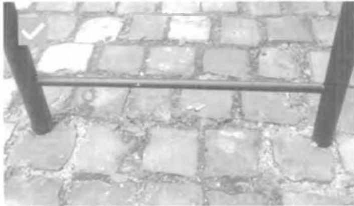
11 Vhodný príklad podpovrchového kotvenia stojane do kamenej dlažby. Vybava špery na umiestnenie pruhu.
