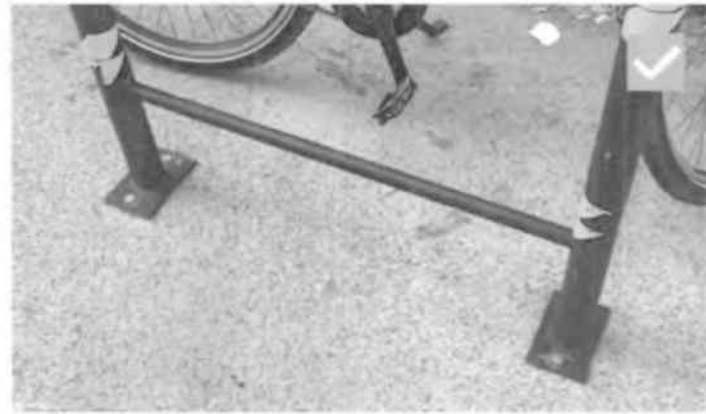
13 Vhodný príklad povrchového kotvenia stojane v kombinácii s vystužením na liatom povrchu. Tento typ kotvenia však nie je vhodný do historického a kompaktného mesta.
