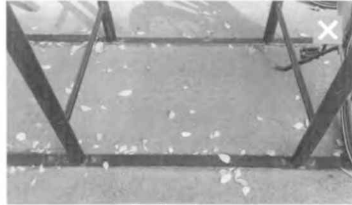
20 Esteticky menej vhodné povrchové kotvenie cyklostojanov pomocou prpojenia jednotlivých stojanov oceľovou pásovinou. Tento typ je nevhodné umiestňovať do historického a kompaktného mesta.
