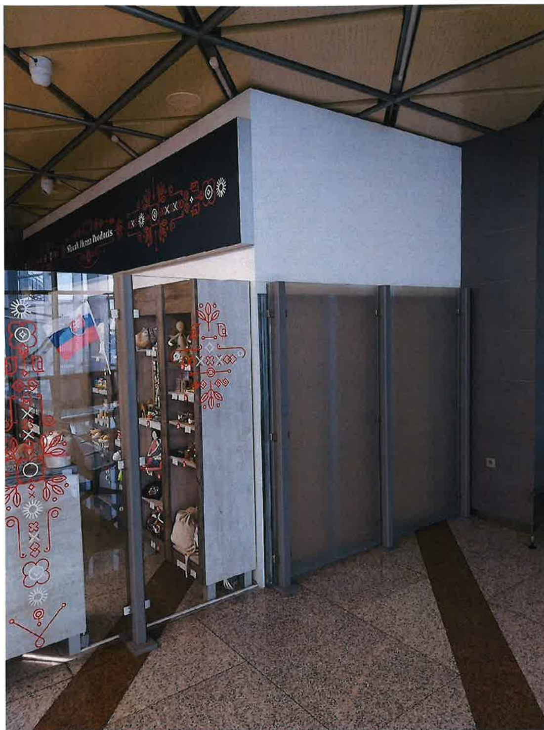
Sadrokartónové priečky s posuvnými dverami do zázemia
