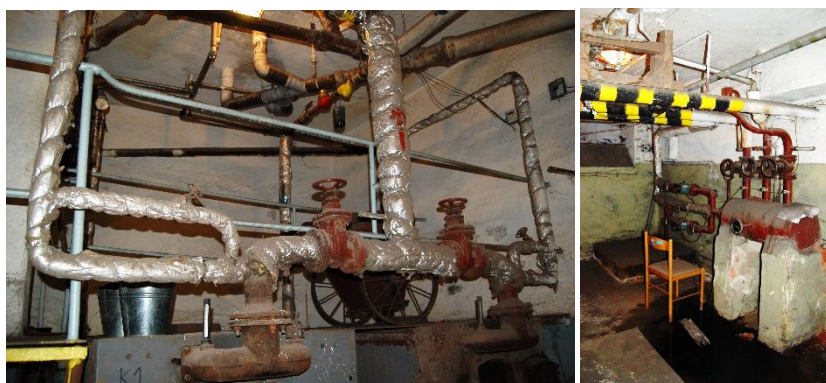
Obr. 18: Vyvedenie tepla, rozdeľovač
