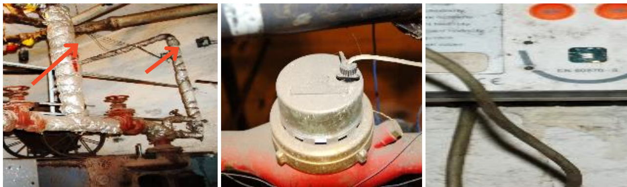
Obr. 13: MT1 – meranie množstva vyrobeného tepla
