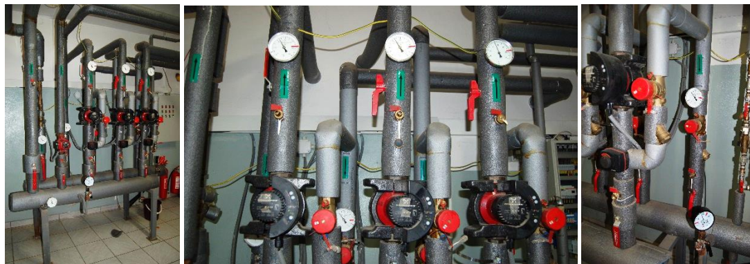
Obr. 7: Rozdeľovač, zberač
