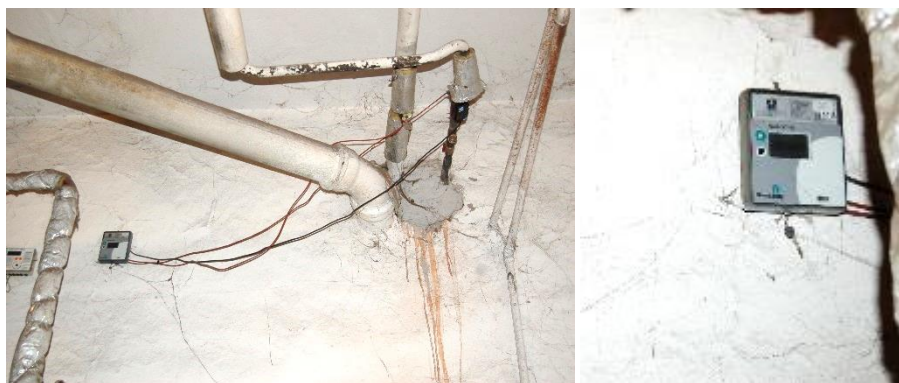
Obr. 14: MT2 – meranie množstva vyrobeného tepla
