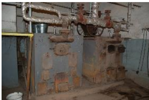
Obr. 17: Inštalované kotly
