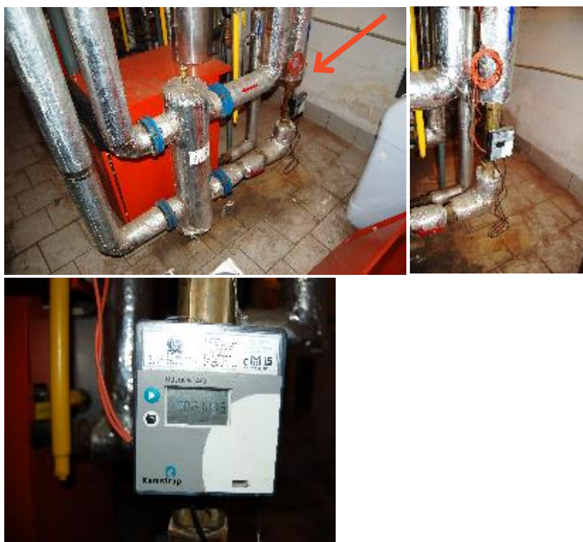
Obr. 24: MT1 – meranie množstva vyrobeného tepla
