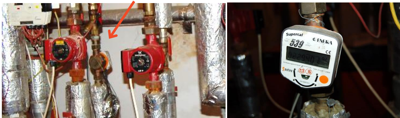
Obr. 25: MT2 – Meranie množstva tepla pre ohrev TV
