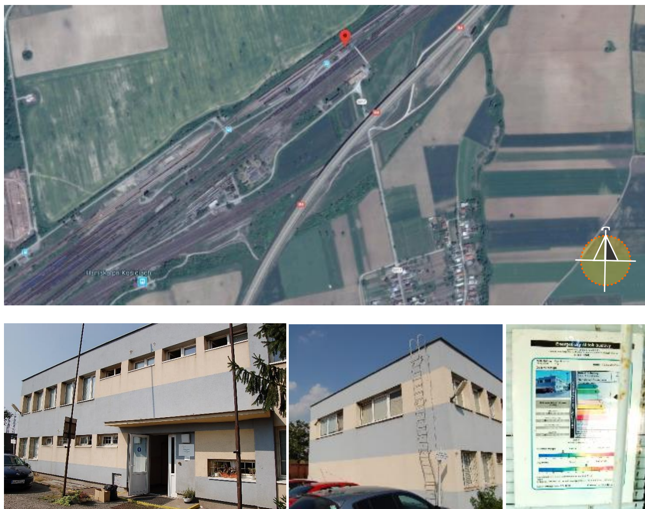
Obr. 21: Situácia širších vzťahov a vzhľad budovy
