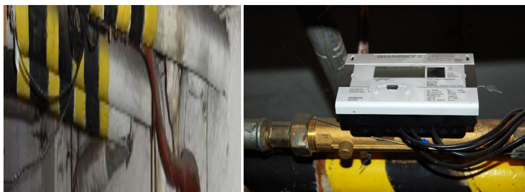
Obr. 15: MT2 – meranie množstva vyrobeného tepla
