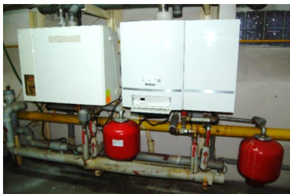
Obr. 36: Inštalované kotly
