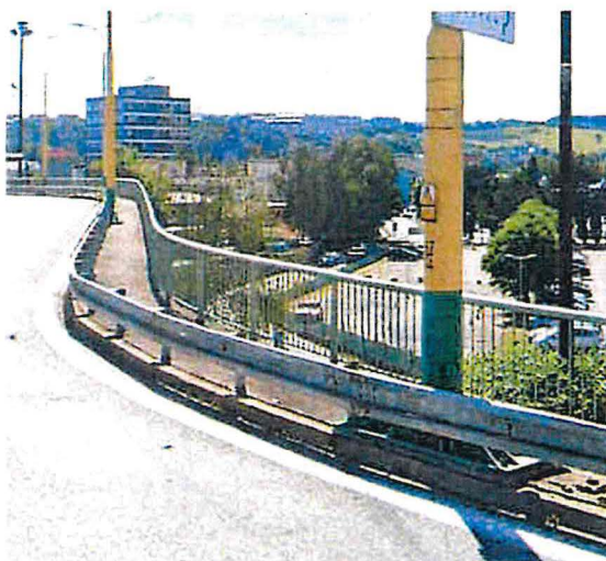
Obrázok 2- Vzorový pohľad na stožiar trakcie s kotvením cez NK – Okružná križovatka Rondel
