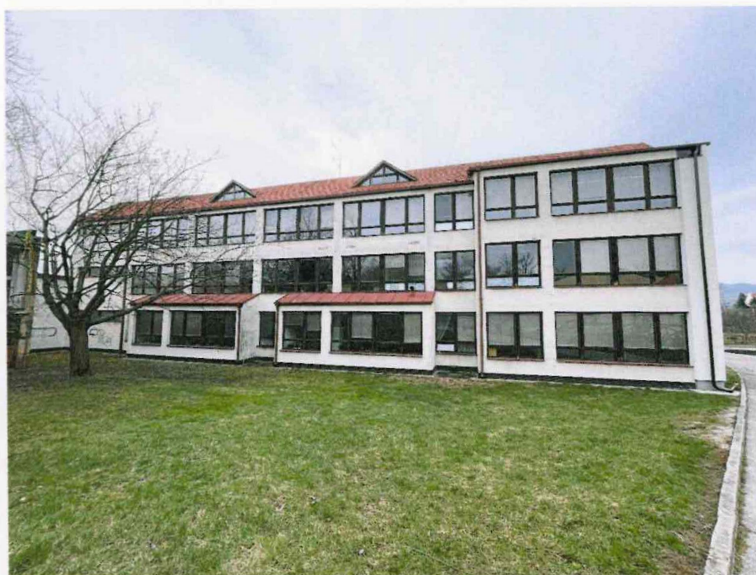
Obrázok 12 Prístavba budovy školy - učebne
