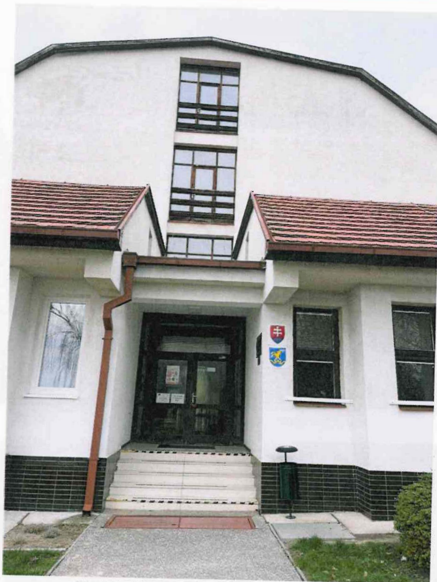
Obrázok 8 Vstup do prístavby budovy školy
