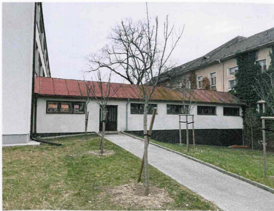
Obrázok 14 Prístavba budovy školy - spojovací krčok
