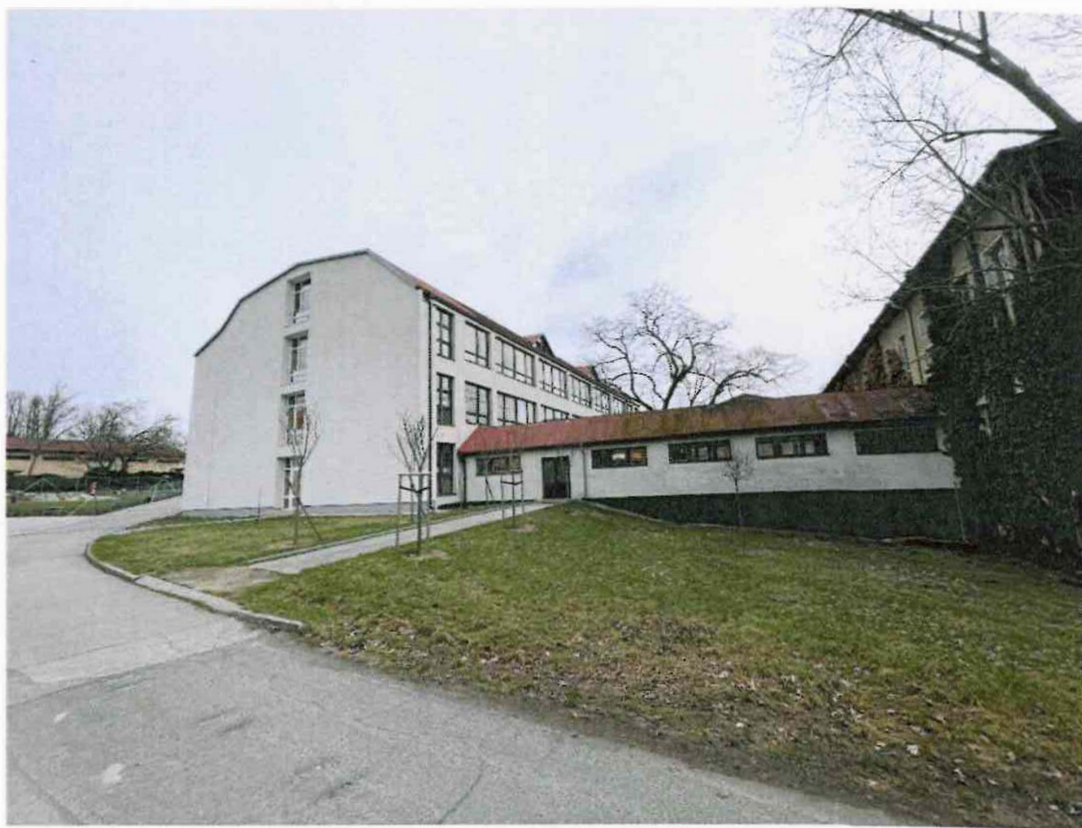
Obrázok 13 Prístavba budovy školy - spojovací krčok
