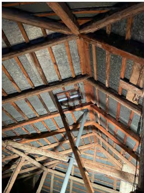
obr.3: Pohľad na drevený krov
