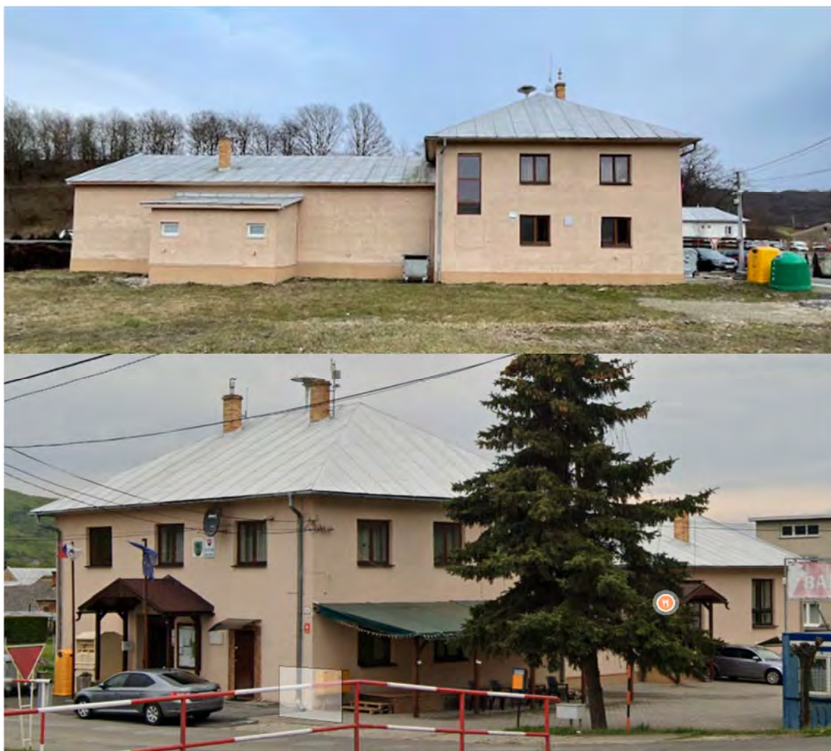
obr.1, 2: Pohľady na budovu
