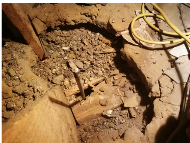
Obr. 4 – sonda v skladbe stropu
