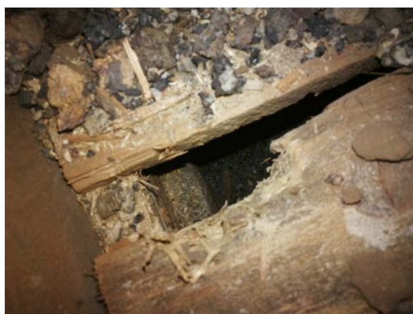
Obr. 3 – sonda v skladbe stropu
