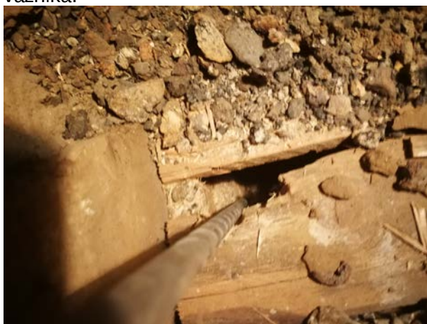
Obr. 2 – sonda v skladbe stropu
