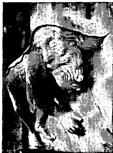
Ukážka farebnosti zoxidovaného oloveného plechu. Oplechovanie hornej časti reliéfu na katedrále sv. Víta v Prahe. zdroj: casopis-stavebnictvi.cz
