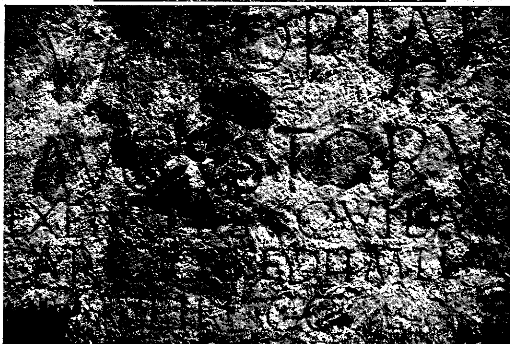
Za mierneho dažďa voda tečie hlavne cez ľavú polovicu nápisového poľa. Práve v strede prúdu stekajúcej dažďovej vody sú poškodené písmená I a C z prvého slova VICTORIAE.
