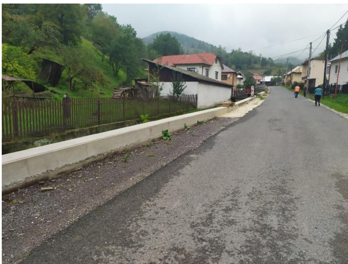
Stav vozovky a nová rímsa - doplnenie zábradlí a odvodnenia
